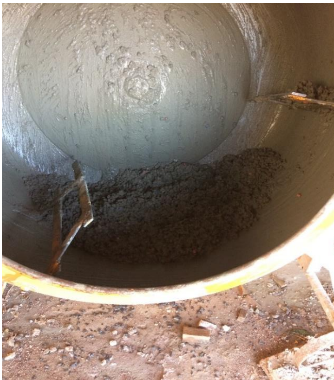
Figura 4 – Imagem fotográfica demonstrativa do preparo do concreto sendo realizado na betoneira.
