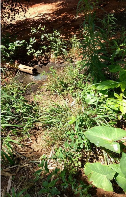
Figura 12 – Disposição de esgoto a céu aberto – 16 de Outubro de 2017
