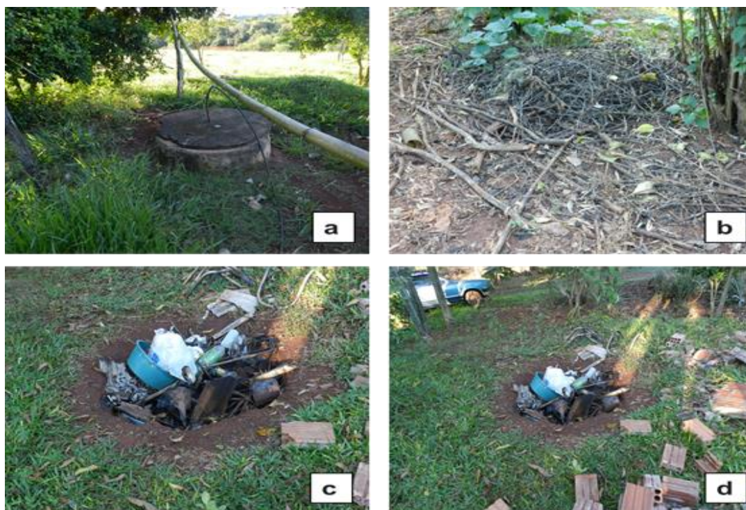
Figura 23 – Lote 130: a) Fossa Séptica b) Poço Artesiano c) e d) Disposição de Resíduos
