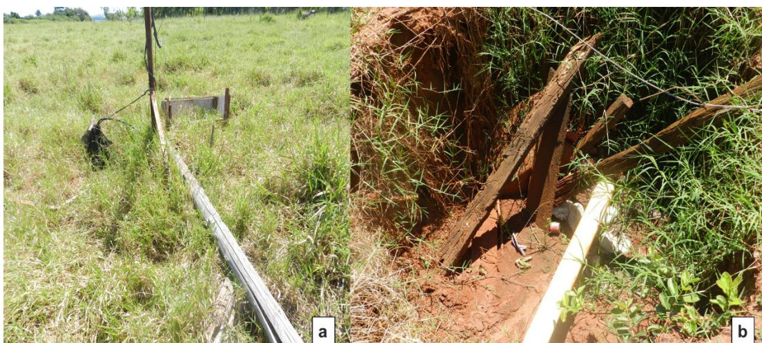
Figura 17 – Condição do ponto 7: a) Poço e b) Fossa;
