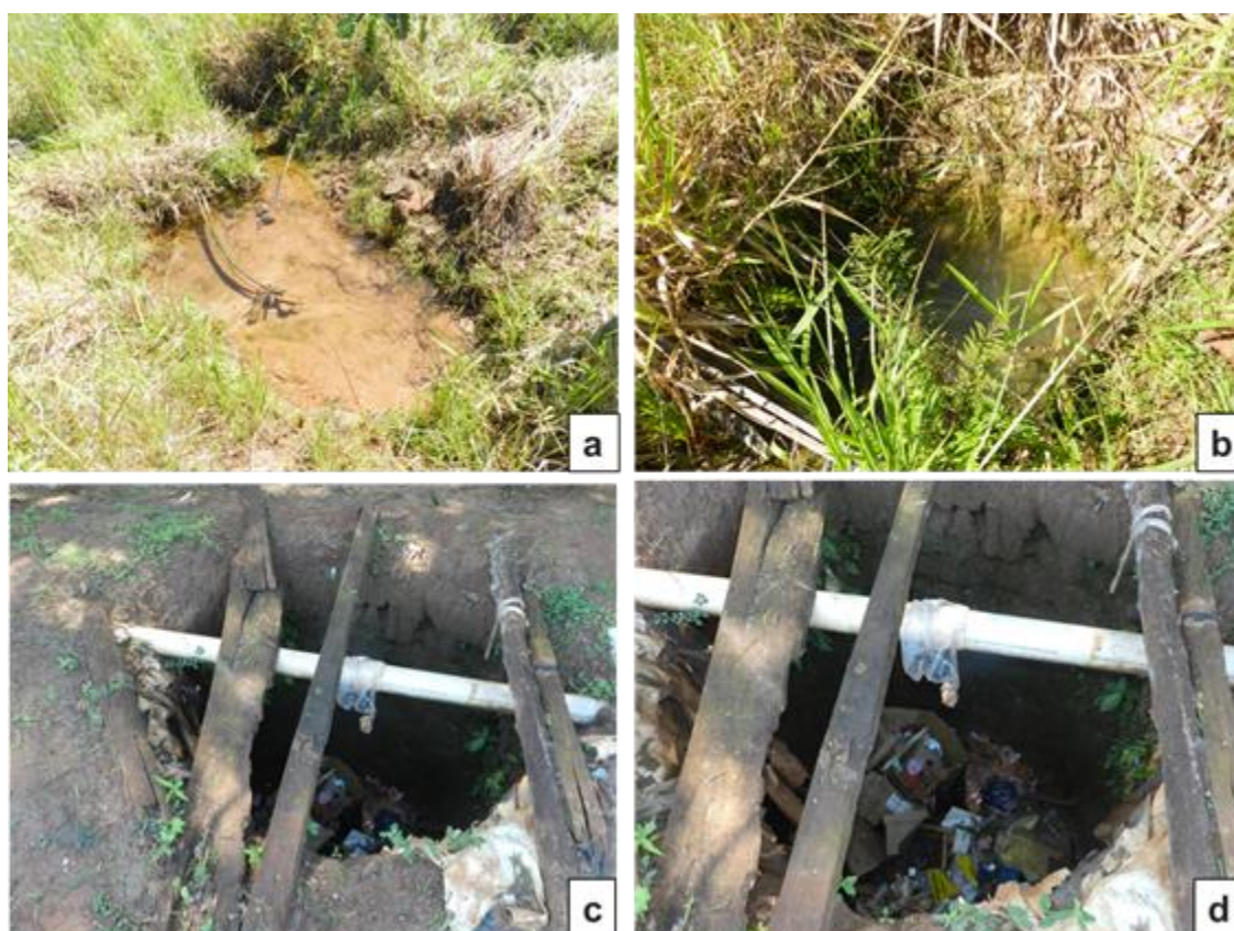
Figura 34 – Lote 103: a-b) nascente. c-d) Fossa Séptica com disposição de resíduos
