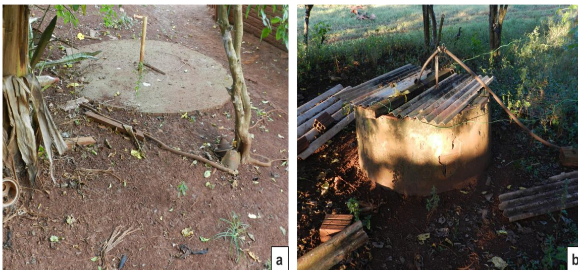
Figura 21 – Condições do Ponto 4: a) Fossa Séptica b) Poço Artesiano
