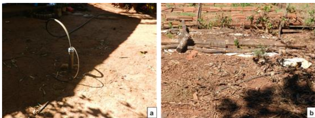
Figura 24 – Lote 34: a) Poço Artesiano b) Fossa Séptica
