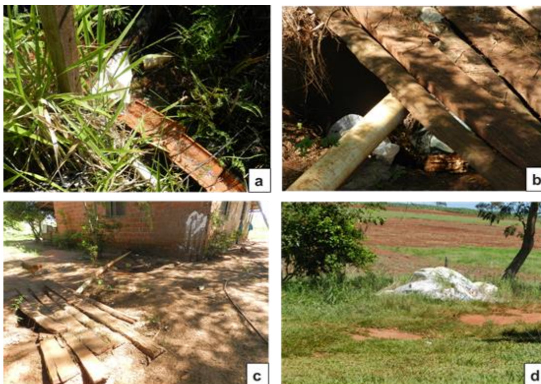
Figura 42 – Lote 161: a) Nascente b) Fossa Séptica c) Fossa Séptica d) Disposição de Resíduos.
