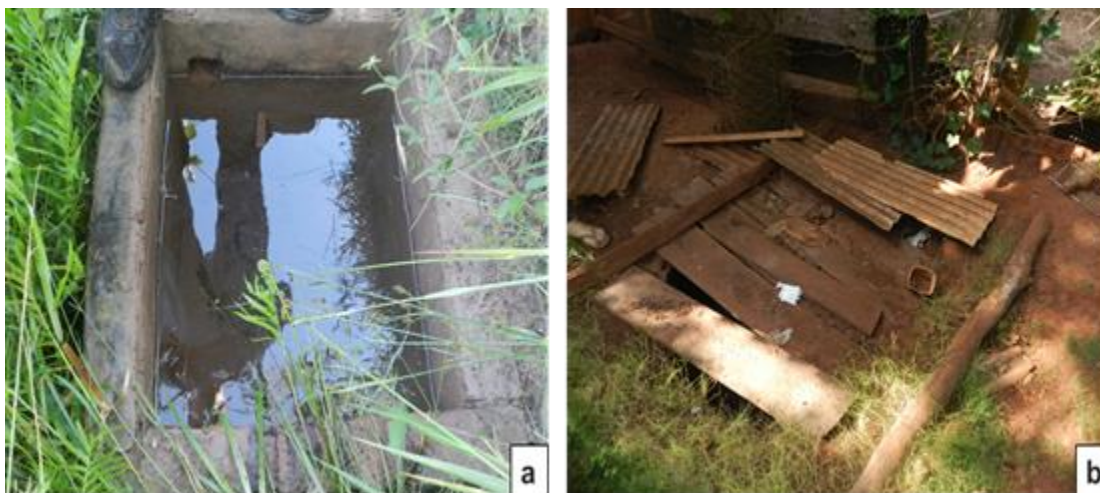
Figura 31 – Lote 109: a) nascente b) Fossa Séptica
