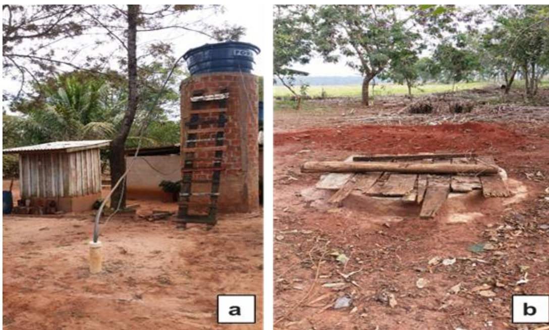
Figura 30 – Sede: a) poço próximo ao banheiro externo. B) fossa.
