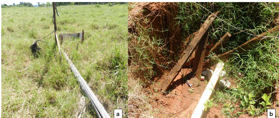
Figura 29 – Lote 233: a) Fossa Séptica b) Biodigestor c) Fossa Séptica desativada
