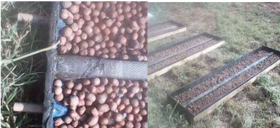
Figura 4: Argila expandida colocada sobre a manta asfáltica para a montagem dos módulos de telhado verde.
