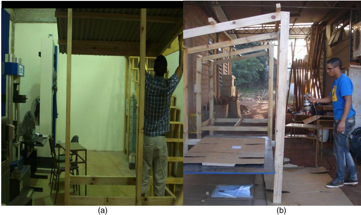
Figura 3 - Estrutura dos protótipos dos cômodos utilizados no experimento: a) Fase de construção, b) Aplicação de stain nas estruturas.
