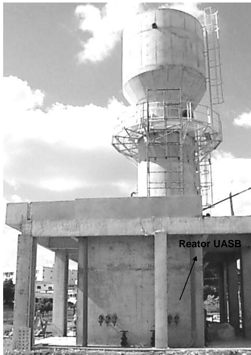
Figura 6 – Reator UASB em escala real.
