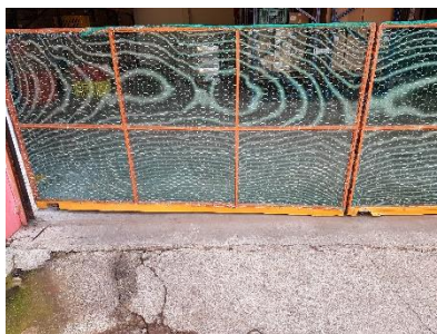
Figura 7. Porta do depósito de Matérias Primas.
