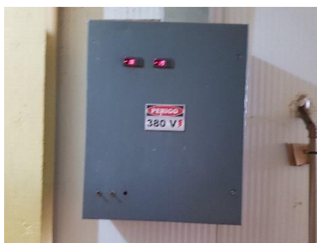
Figura 16. Painel de controle de temperatura da Câmara fria
