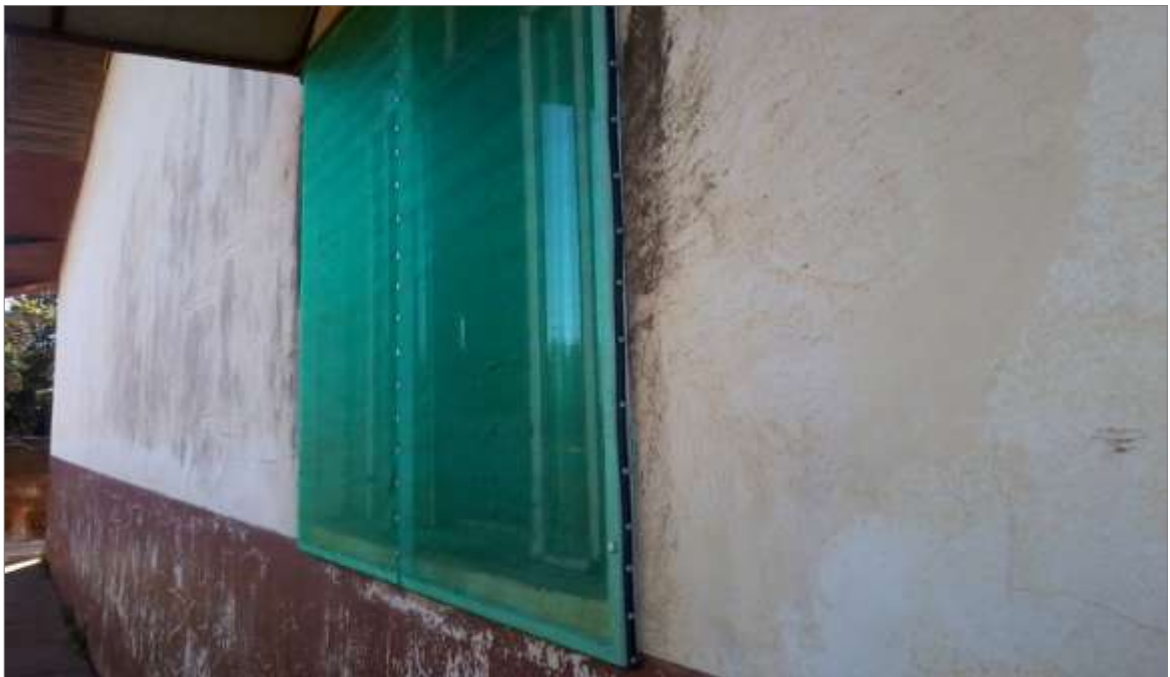
Foto 2: Janelas da área de produção, protegidas por telas, após a implantação da BPF
