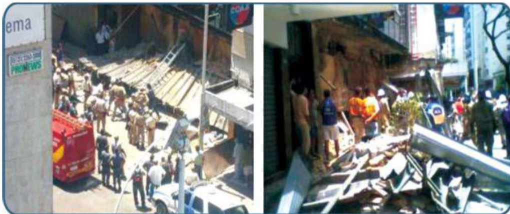
Foto 2: Queda da marquise do Hotel Canadá no Rio de Janeiro (Fonte: HELENE, 2008)
