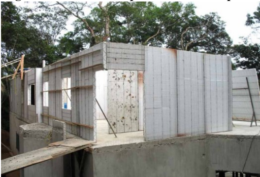
Figura 19 - Antes e depois da obra de Iporanga/SP - parte externa
