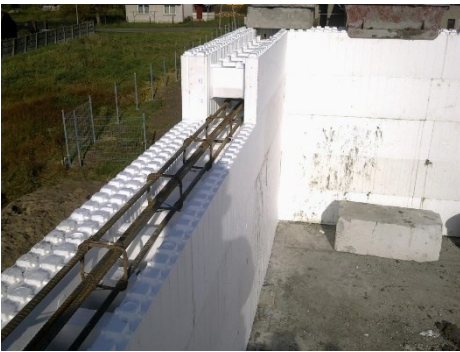
Figura 28 - Disposição das armaduras no interior dos blocos de EPS
