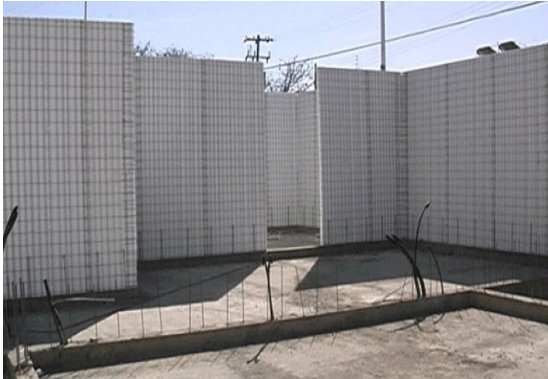
Figura 9 - Fixação e escoramento das placas de EPS
