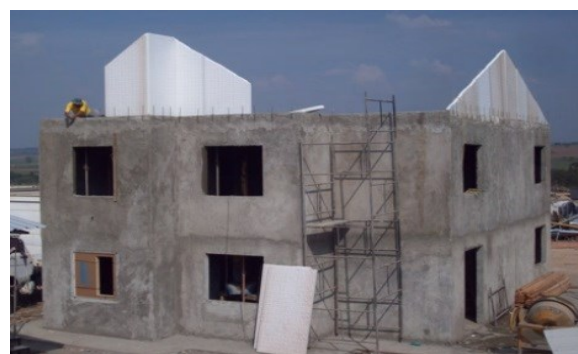
Figura 15 - Revestimento externo com aspecto de alvenaria convencional
