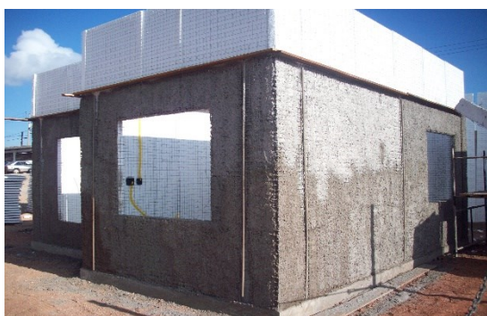
Figura 15 - Revestimento externo com aspecto de alvenaria convencional
