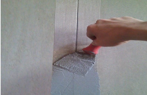
Figura 47 - Tratamento das juntas e aplicação de massa cimentícea
