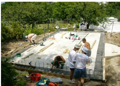
Figura 53 - Fundação com esperas de aço
