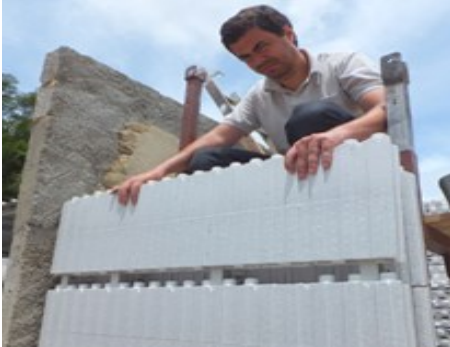
Figura 27 - Encaixe dos blocos de EPS
