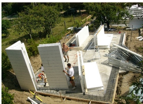
Figura 54 - Painéis de vedação com adição de armaduras
