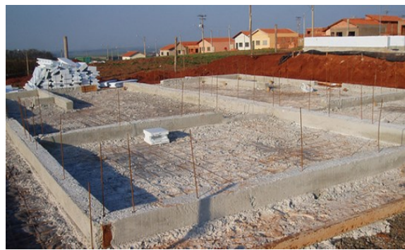
Figura 26 - Fundação do tipo laje radier com esperas de aço e viga baldrame
