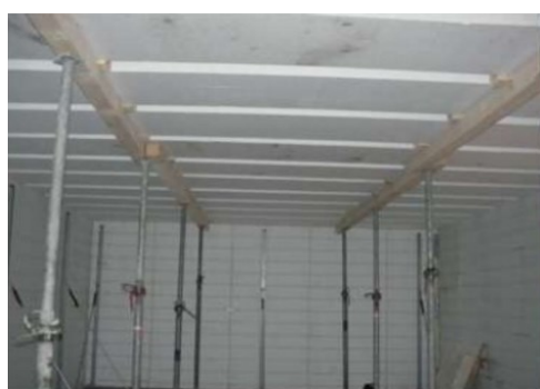
Figura 57 - Concretagem de paredes e laje
