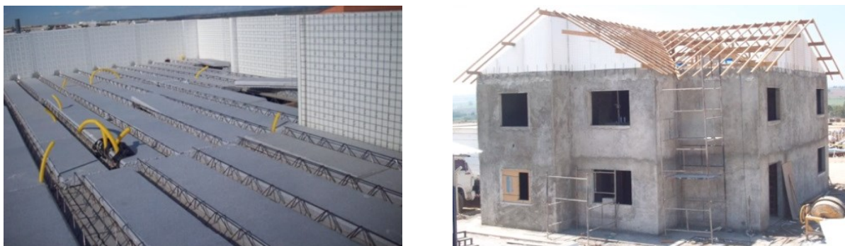
Figura 17 - Instalação da laje e madeiramento na cobertura
