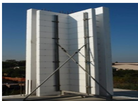
Figura 55 - Escoramento dos painéis
