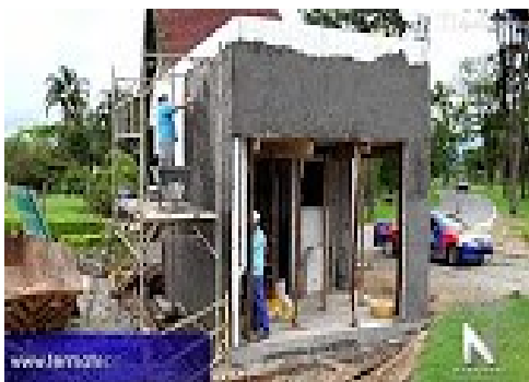
Figura 59 - Revestimento sobre EPS - conjuntos habitacionais
