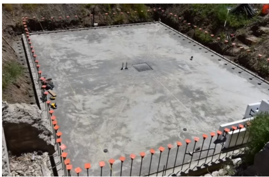
Figura 26 - Fundação do tipo laje radier com esperas de aço e viga baldrame
