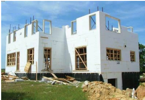
Figura 30 - Abertura de esquadrias e impermeabilização
