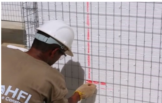
Figura 11 - Montagem e abertura de fendas nos painéis de EPS
