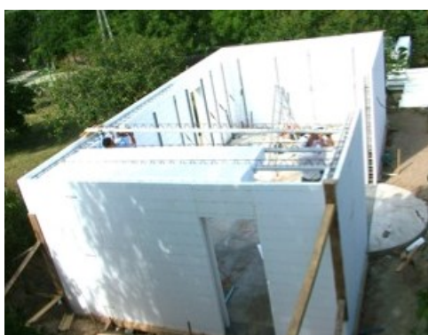
Figura 56 - Montagem da laje com inserção de malhas de aço
