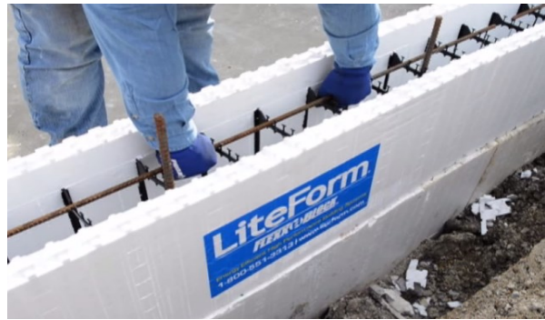
Figura 28 - Disposição das armaduras no interior dos blocos de EPS
