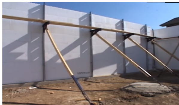
Figura 29 - Concretagem das paredes de EPS e instalação dos aprumadores
