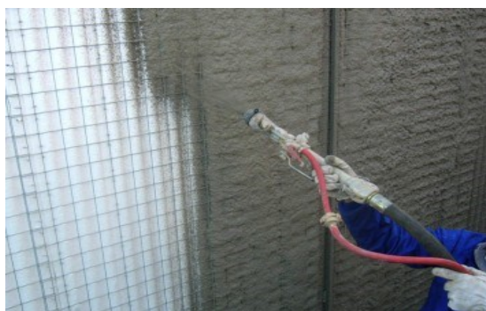
Figura 14 - Jateamento de concreto e sarrafeamento
