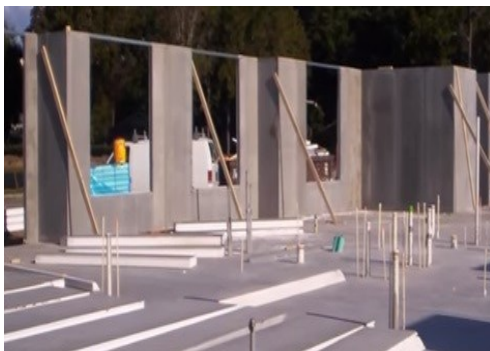
Figura 44 - Montagem e detalhe da fixação entre os painéis
