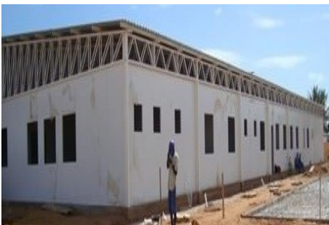
Figura 46 - Cobertura metálica em obra de hospital
