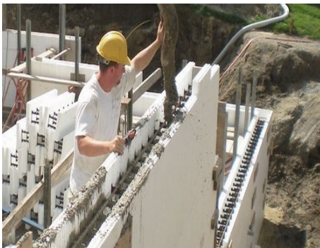
Figura 29 - Concretagem das paredes de EPS e instalação dos aprumadores
