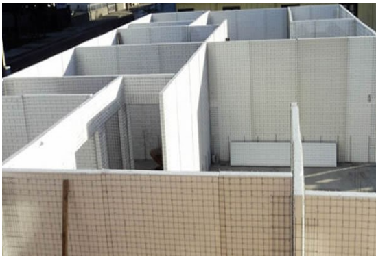
Figura 10 – Divisórias e união das malhas de aço
