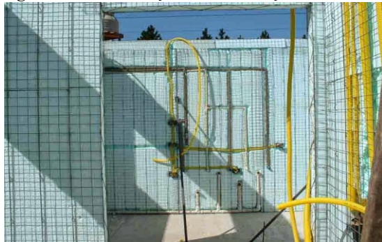
Figura 13 - Finalização das instalações e detalhe do caixilho
