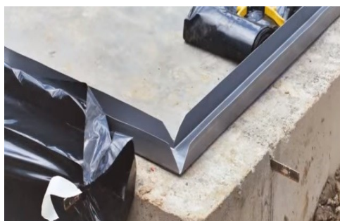
Figura 41 - Fixação de perfis de aço à laje radier
