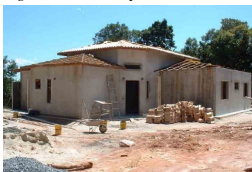
Figura 23 - Antes e depois da obra de Jarinu/SP - fachada
