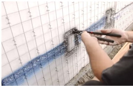
Figura 12 - Corte da tela metálica e passagem da tubulação sob a malha de aço
