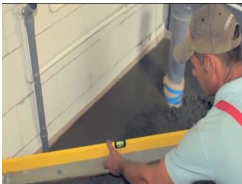
Figura 58 - Passagem das tubulações
