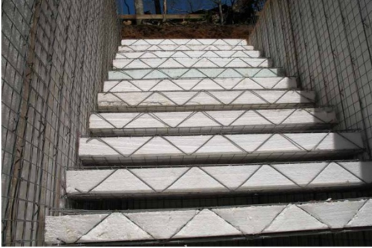
Figura 18 - Antes e depois da obra de Iporanga/SP – parte da escada
