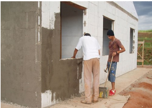
Figura 33 - Revestimento 1º e 2º demão
