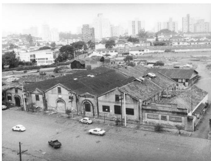
Figura 12 - Imagem do Matadouro desativado. Fonte: Almeida (2012).
