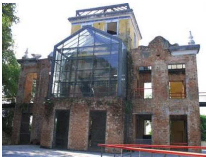
Figura 36 - Centro Culturais Parque das Ruínas. Fonte: Teobaldo (2004).
