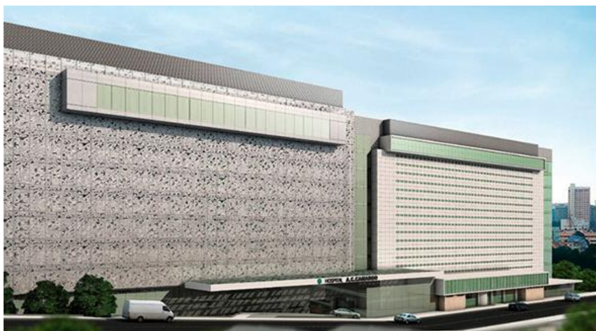
Figura 27 - Perspectiva da fachada com distinção clara entre a fachada restaurada e a fachada adjacente.
