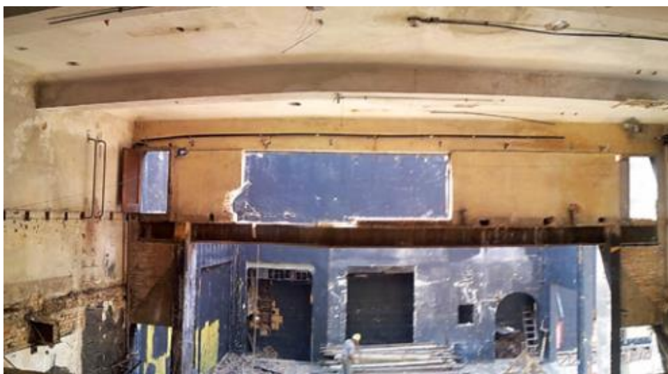
Figura 42 - As vigas receberam reforço com perfis I de 400 milímetros na face inferior. Fonte: Revista Construção Metálica (2014).
