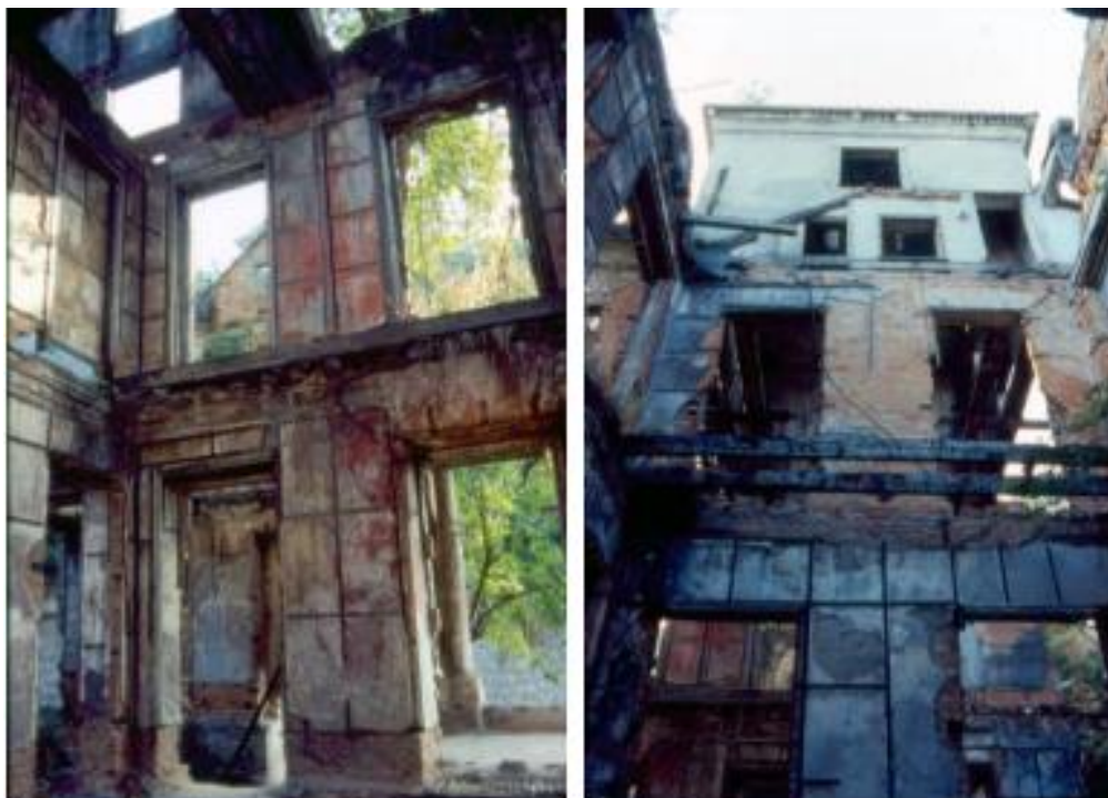
Figura 33 - Interior da casa antes do Retrofit, com destaque o desmoronamento dos pisos e parte do telhado. Fonte: Moraes (2009).
