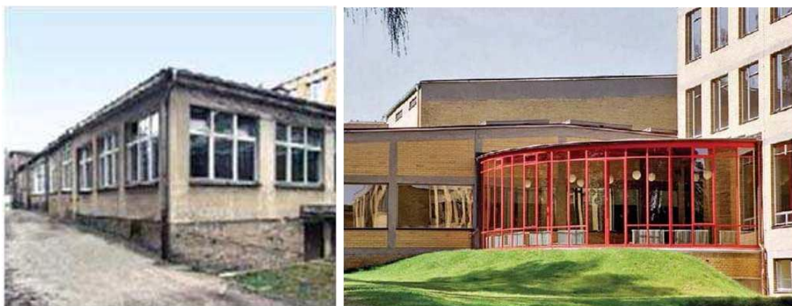
Figura 44 - Intervenção antiga à esquerda e novo Retrofit à direita. Fonte: Gomes (2015).
