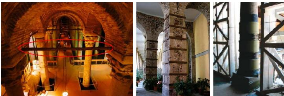
Figura 8 - À esquerda, Igreja de Santa Sofia com perfil metálico chumbado na estrutura; ao centro, Palácio Nacional e à direita, Antiga Escola de Medicina, ambos na Cidade do México, com reforço com anéis metálicos.
