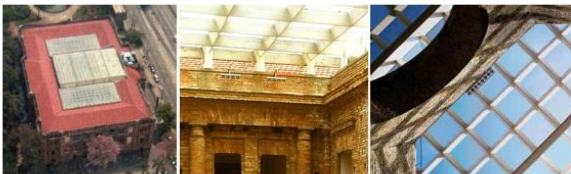
Figura 19 - Detalhe da claraboia na cobertura da Pinacoteca. Fonte: Moraes (2009).
