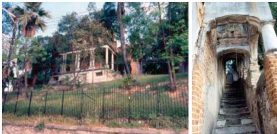
Figura 34 - Parte externa da edificação antes do Retrofit. Fonte: Moraes (2009).
