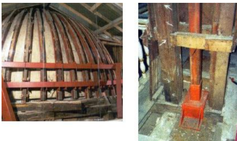
Figura 9 - Cúpula da Igreja de São Cristóvão e detalhe de pilar de aço inserido no arco.
