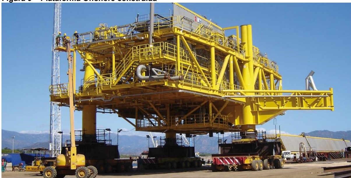
Figura 9 – Plataforma Offshore construída
