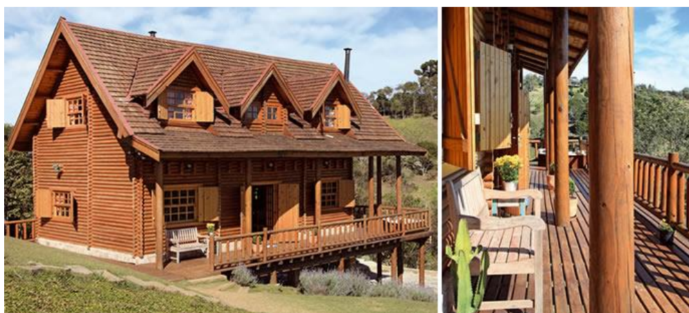
Figura 3 - Residência sustentada por pilares de madeira pínus Fonte: Revista construir mais por menos disponível no Portal Casa e Cia. 1
