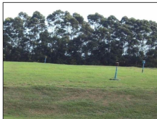
Figura 69 – Queimadores célula finalizada Fonte: Autoria própria, (2015).
