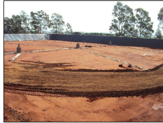
Figura 56– Capa de solo argiloso para proteção mecânica Fonte: Aatoria própria, (2015).
