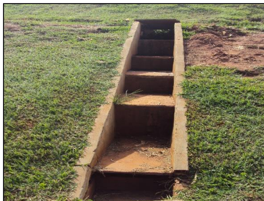
Figura 67 – Escadas dissipadoras para água pluvial
