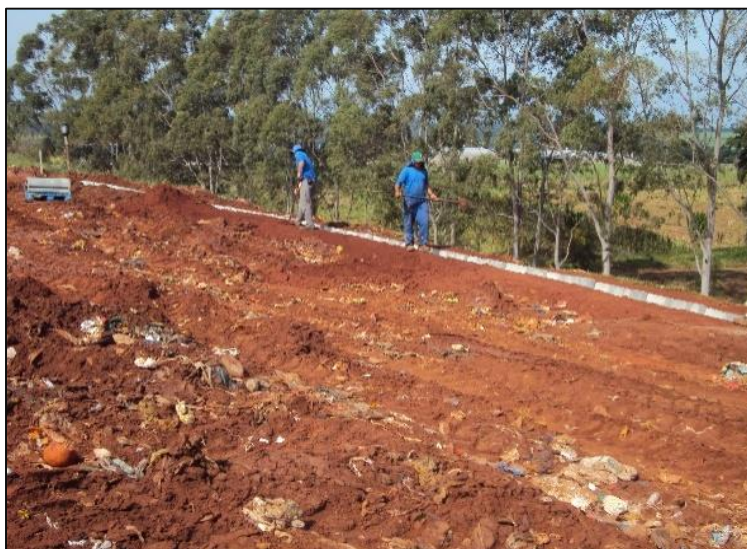
Figura 64– Canaleta de água pluvial sendo instalada próxima à frente de trabalho Fonte: Autorial própria, (2015)
