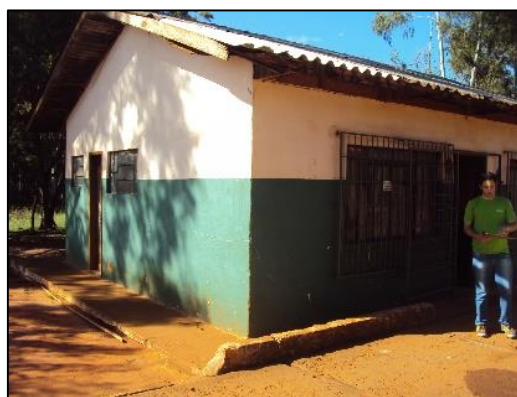
Figura 10 – Guarita utilizada para vigilância. Fonte: Autoria própria, (2015).
