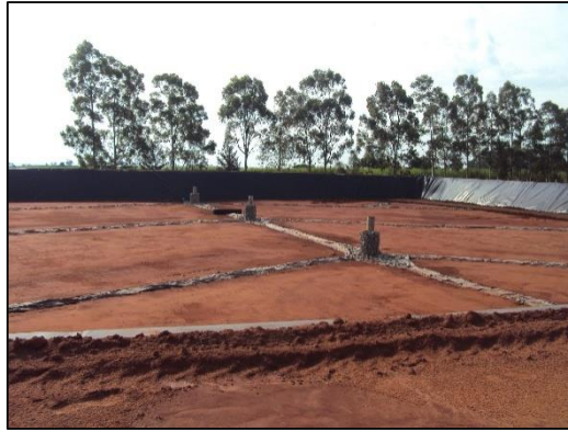
Figura 59– Drenos de chorume na forma de espinha de peixe Fonte: Aatoria própria, (2015).
