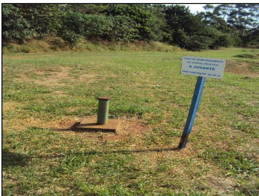
Figura 70 – Poço a jusante do aterro sanitário
