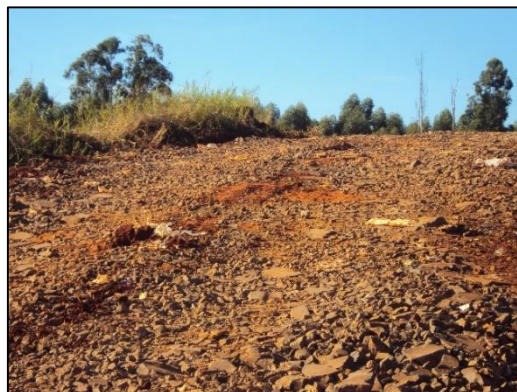
Figura 16 – Vias de acesso revestidas com brita. Fonte: Autoria própria, (2015).
