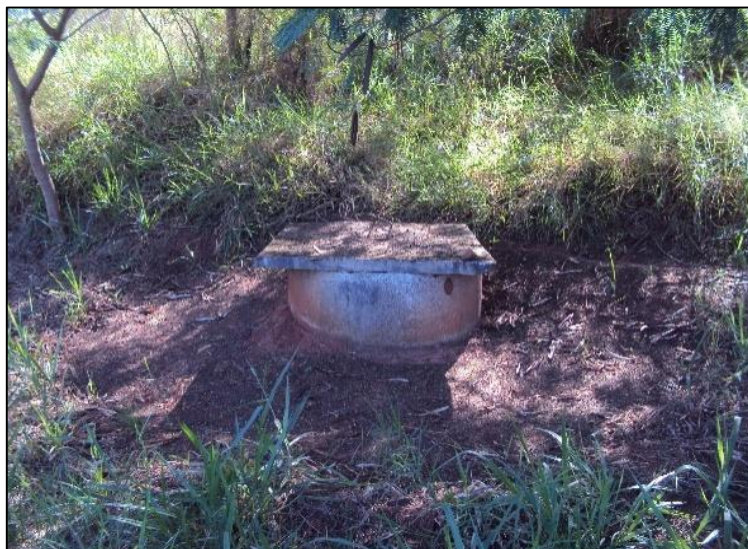
Figura 25 – Galeria de escoamento de chorume. Fonte: Autoria própria, (2015).
