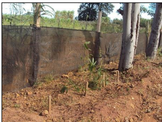
Figura 40 – Tela plástica utilizada próximo a frente trabalho Fonte: Autoria própria, (2015).
