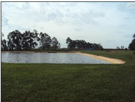
Figura 60– Lagoa anaeróbia Fonte: Aatoria própria, (2015).
