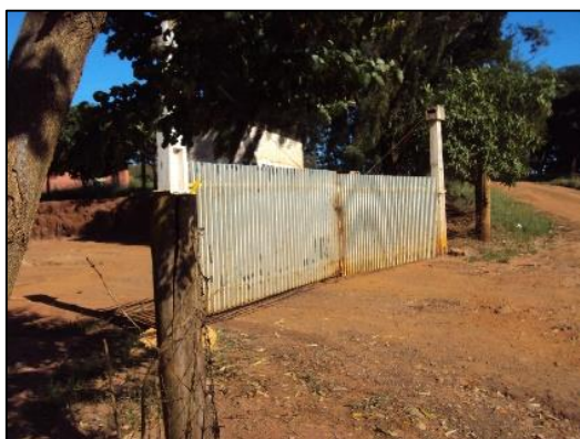
Figura 7 – Portaria de acesso ao aterro. Fonte: Autoria própria, (2015).
