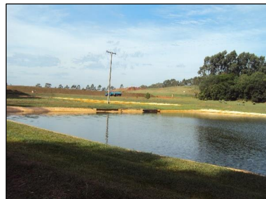
Figura 63 – Lagoa de infiltração adaptada para recirculação Fonte: Aatoria própria, (2015).
