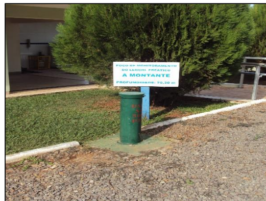
Figura 71 – Poço a montante do aterro sanitário
