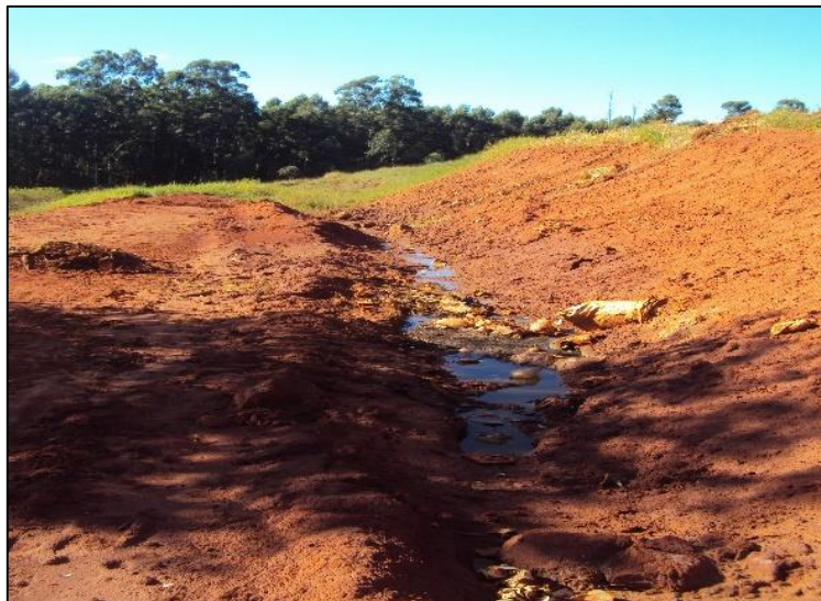
Figura 24 – Afloramento de chorume na lateral da célula. Fonte: Autoria própria, (2015).
