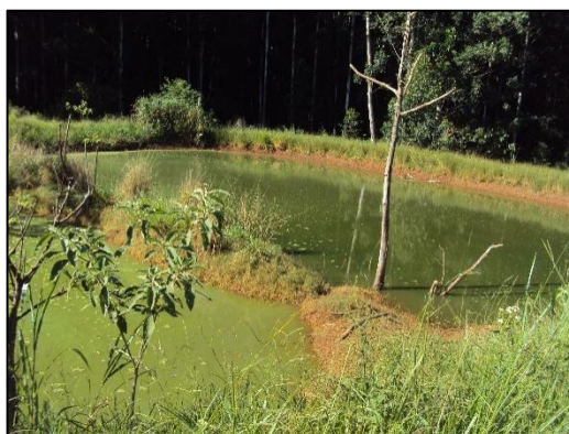
Figura 28 – Lagoa de infiltração. Fonte: Autoria própria, (2015).
