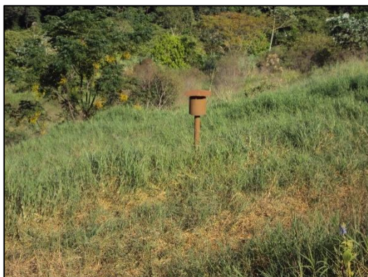
Figura 30 – Queimador manual na área finalizada. Fonte: Autoria própria, (2015).
