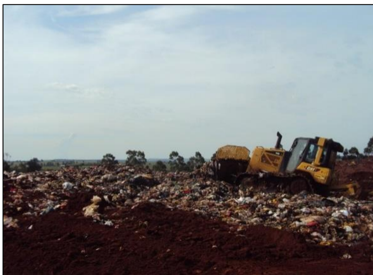
Figura 50– Recobrimento da camada intermediária de resíduo Fonte: Aatoria própria, (2015).
