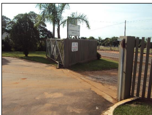
Figura 38 – Portaria de acesso ao aterro Fonte: Autoria própria, (2015).
