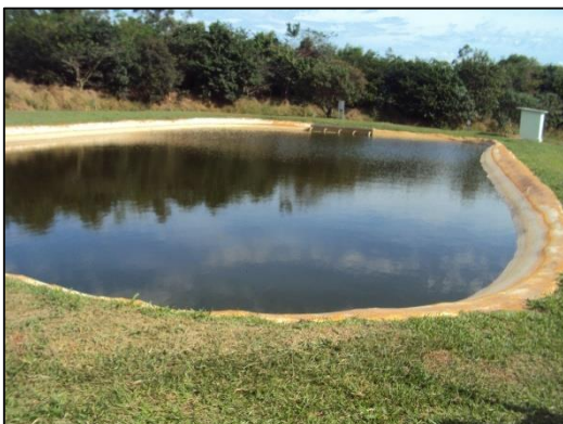
Figura 62– Lagoa de polimento Fonte: Aatoria própria, (2015).
