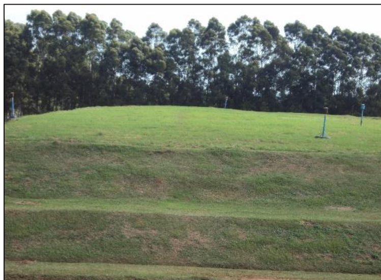
Figura 53– Cobertura Vegetal presente na célula finalizada Fonte: Autoria própria, (2015).
