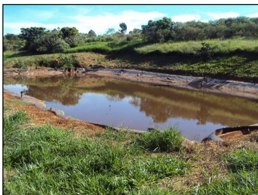
Figura 26– Lagoa anaeróbia Fonte: Autoria própria, (2015).
