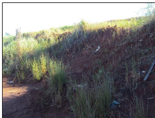
Figura 21 – Vista lateral do talude desmoronado Fonte: Aatoria própria, (2015)
