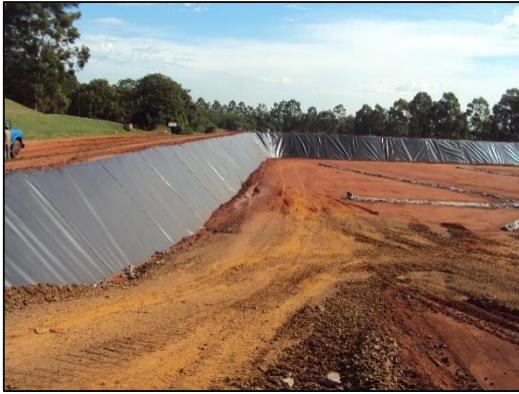
Figura 55 – Geomebrana envolvendo toda a lateral da trincheira Fonte: Aatoria própria, (2015).
