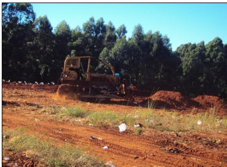
Figura 19 – Trator de esteira utilizado para compactação de resíduo.
