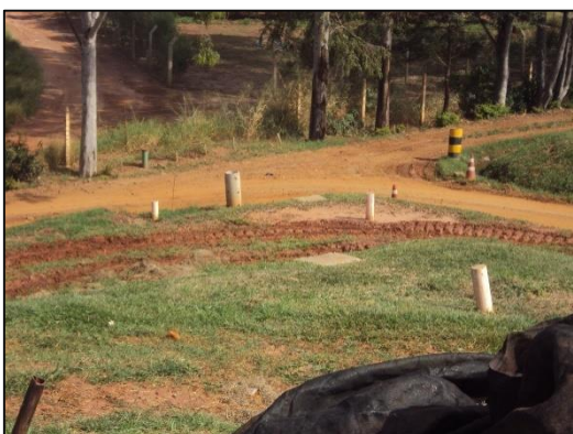
Figura 72 – Marcos superficiais de concreto na extremidades da célula
