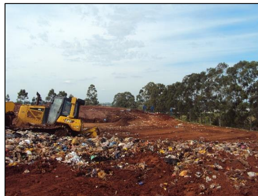
Figura 46 – Acesso à frente de trabalho. Fonte: Aatoria própria, (2015).
