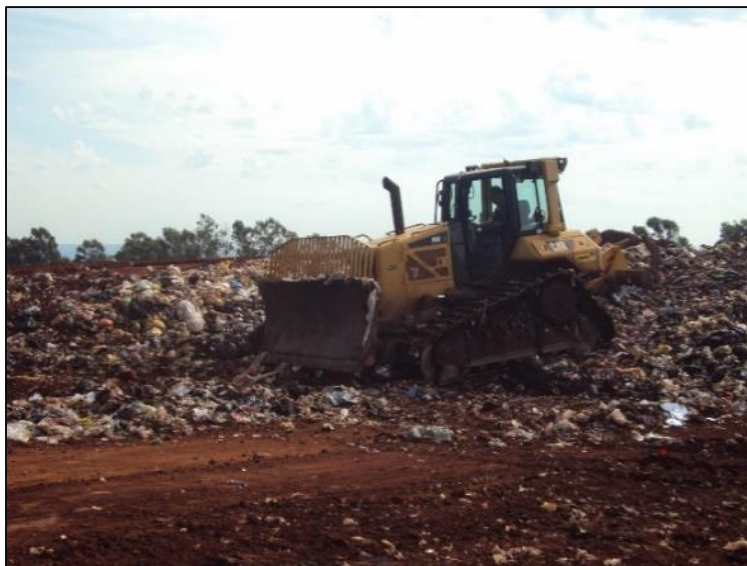
Figura 49 – Trator esteira utilizado para a compactação do resíduo Fonte: Aatoria própria, (2015).
