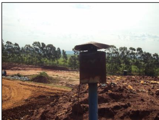
Figura 68 – Queimador Fonte: Autoria própria, (2015).
