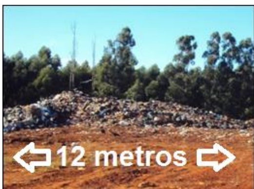
Figura 17 – Perfil da frente de trabalho. Fonte: Autoria própria, (2015).
