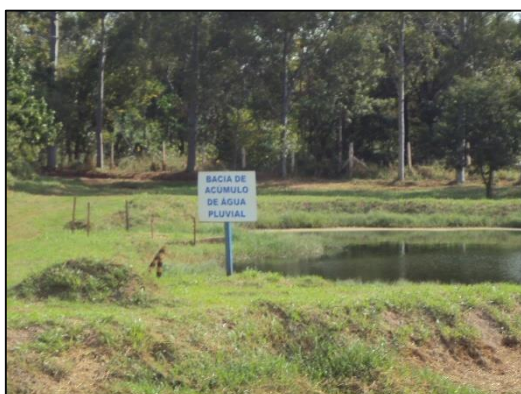
Figura 65 – Lagoa de acumulo de água pluvial Fonte: Autorial própria, (2015)
