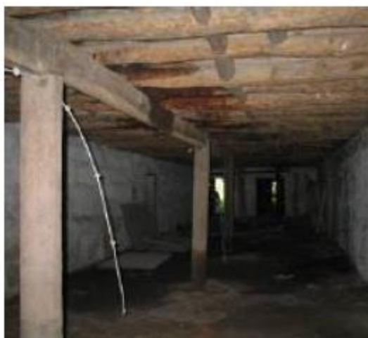
Figura 10 - Utilização de viga de reforço transversal apoiada em pilares de madeira Fonte: Costa et al. (2007 apud COSTA, 2009)
