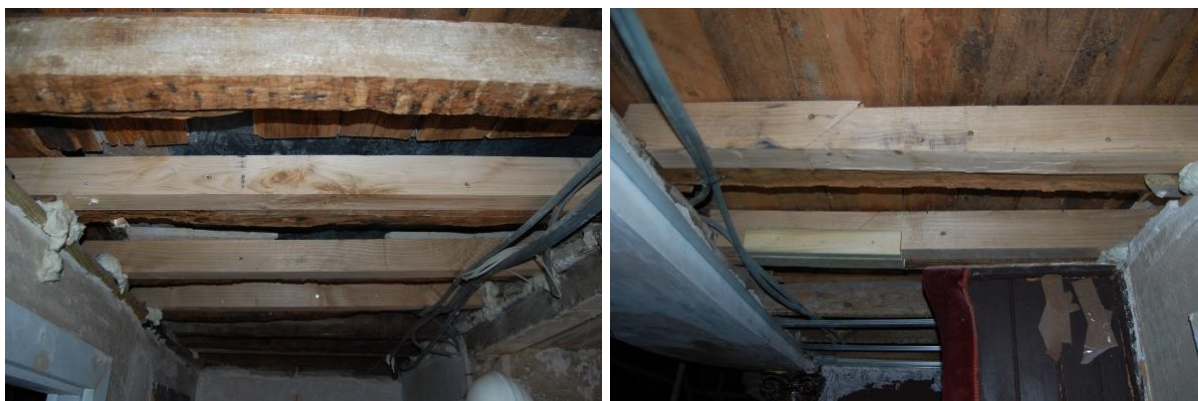
Figura 30 – Reforço de vigas do 1º pavimento com a colocação de novos elementos Fonte: Costa (2009)
