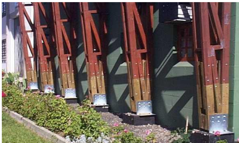
Figura 28 – Vista geral dos pórticos após o processo de substituição das peças Fonte: Fiorelli et al. (2002)
