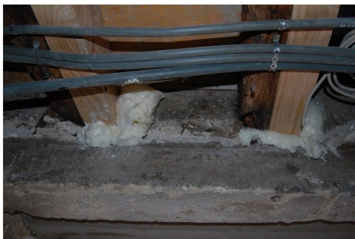
Figura 32 – Reforço dos apoios com uso de argamassa epoxídica Fonte: Costa (2009)
