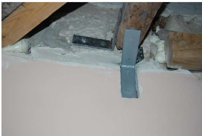
Figura 31 – Reforço do apoio das vigas dos pavimentos com elementos metálicos Fonte: Costa (2009)
