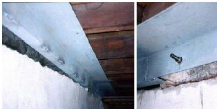
Figura 18 - Vigamento apoiada em cantoneira metálica Fonte: Guedes et al. (2002 apud DIAS, 2008)
