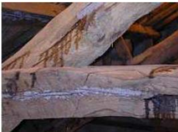
Figura 19 – Preenchimento de fissuras com resina epoxídica Fonte: Lopes (2007)
