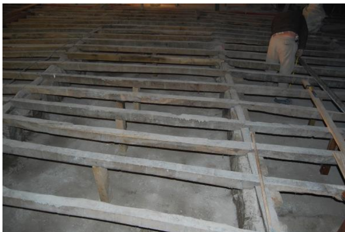
Figura 29 – Reforço do pavimento do piso térreo com recurso de escoras de madeira Fonte: Costa (2009)
