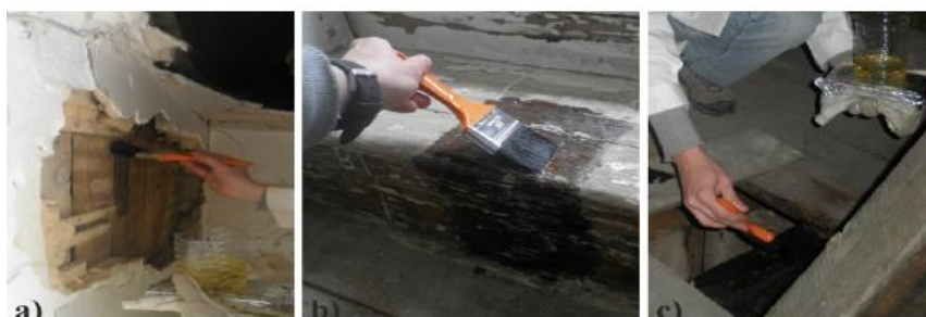
Figura 26 – Aplicação do consolidante a) Costaneira; b) Escada; c) Vigas do pavimento Fonte: Neves (2013)
