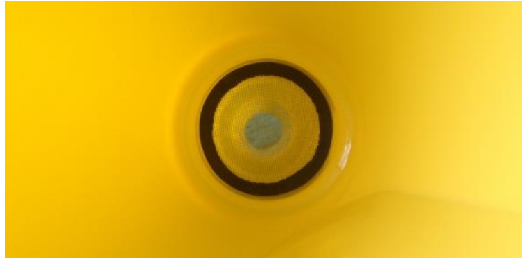
Figura 18 - Tela metálica entre o coletor e reservatório Fonte: Autoria própria (2015)
