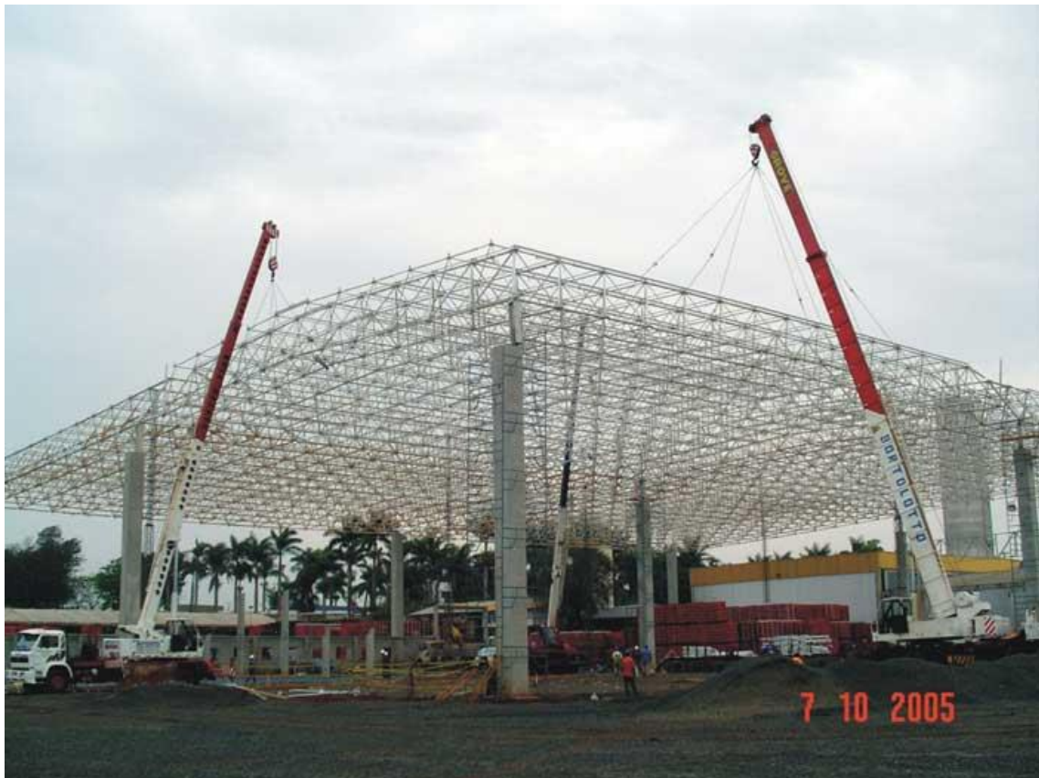
Figura 2.5 – Execução de Cobertura em Treliça Espacial Fonte: Portal Metálica.
