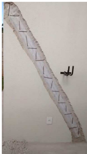
Figura 28 – Recuperação de fissura com introdução de grampos de aço Fonte: Cedido por Bruno Zulin (2016)
