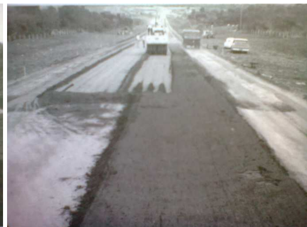
Figura 18 – Compactação do solo-cimento usinado Fonte: SENÇO (2001).
