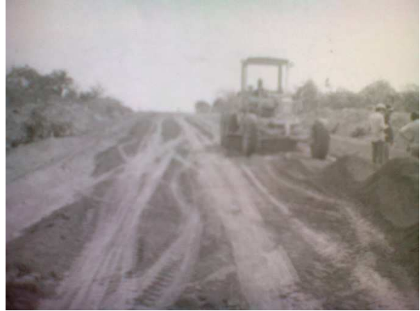
Figura 8 – Espalhamento do solo na pista Fonte: SENÇO (2001).
