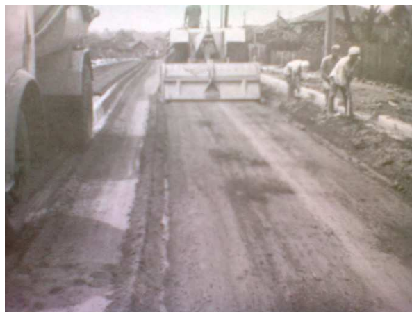
Figura 11 – Adição de água à mistura Fonte: SENÇO (2001).
