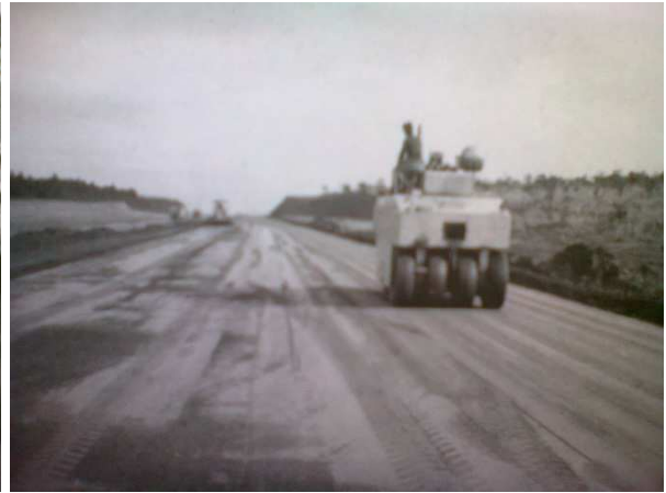
Figura 20 – Acabamento com rolo pneumático, liso, bamboleante Fonte: SENÇO (2001).
