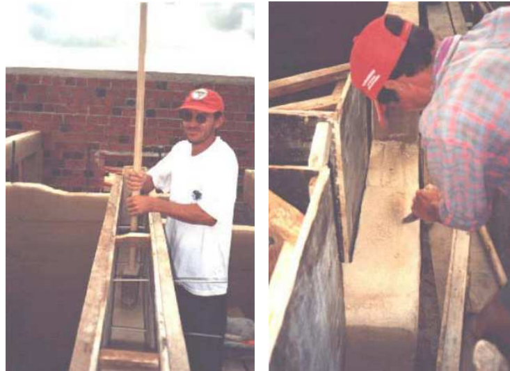
Figura 23 – Soquete de compactação e execução de ranhuras Fonte: (SOARES, TOMAZETTI, PINHEIRO, 2004).
