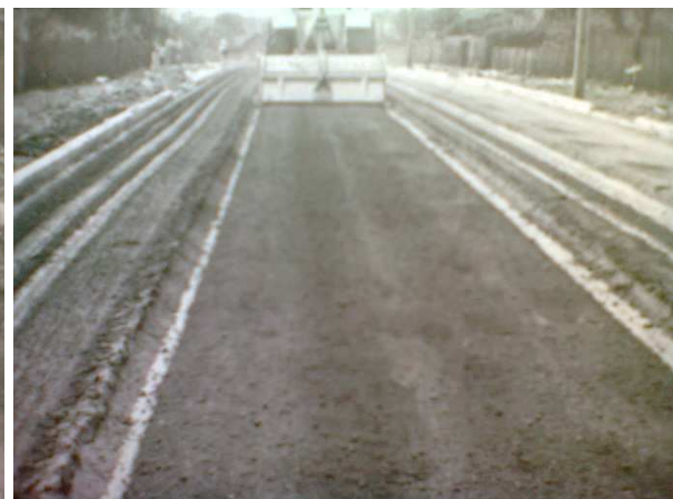
Figura 12 – Mistura do solo e cimento úmida Fonte: SENÇO (2001).
