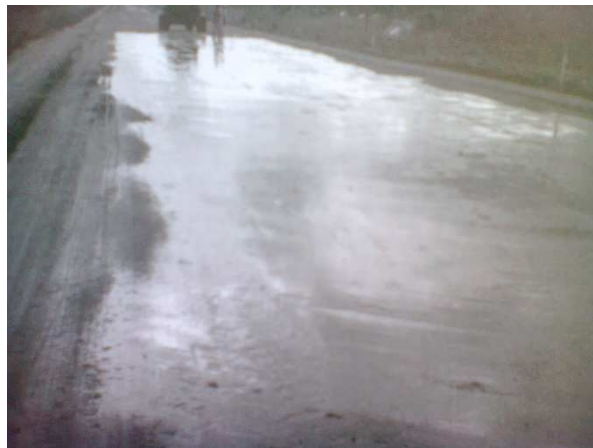
Figura 21 – Solo-cimento imprimado Fonte: SENÇO (2001).
