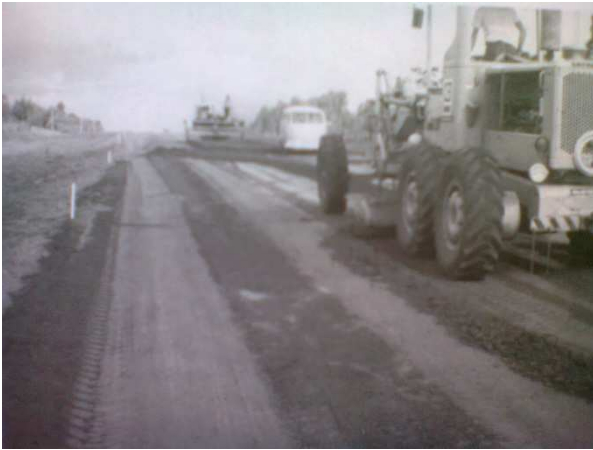
Figura 19 – Regularização da camada solo-cimento com motoniveladora Fonte: SENÇO (2001).
