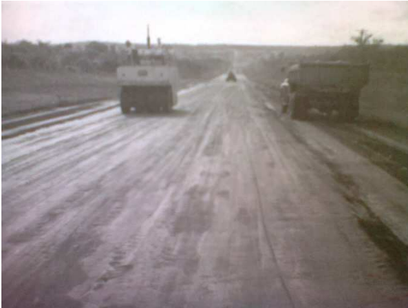
Figura 15 – Compactação final com rolo pneumático liso Fonte: SENÇO (2001).
