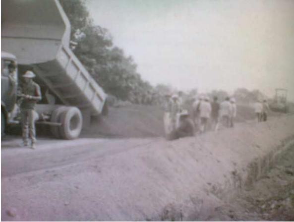
Figura 7 – Descarga do solo escolhido na pista Fonte: SENÇO (2001).
