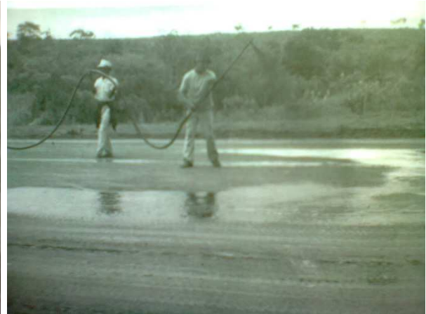
Figura 16 – Pintura asfáltica para cura da base de solo-cimento Fonte: SENÇO (2001).
