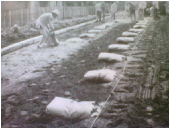
Figura 9 – Adição e espalhamento do cimento Fonte: SENÇO (2001).
