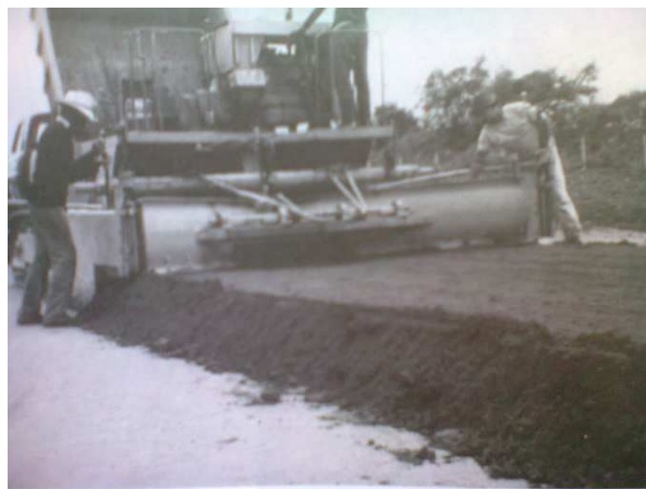
Figura 17 – Distribuição do solo-cimento usinado Fonte: SENÇO (2001).
