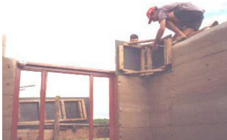
Figura 22 – Montagem da forma
