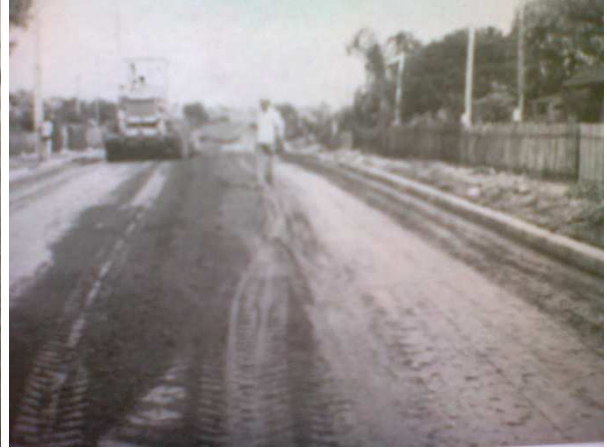
Figura 14 – Regularização final com motoniveladora Fonte: SENÇO (2001).
