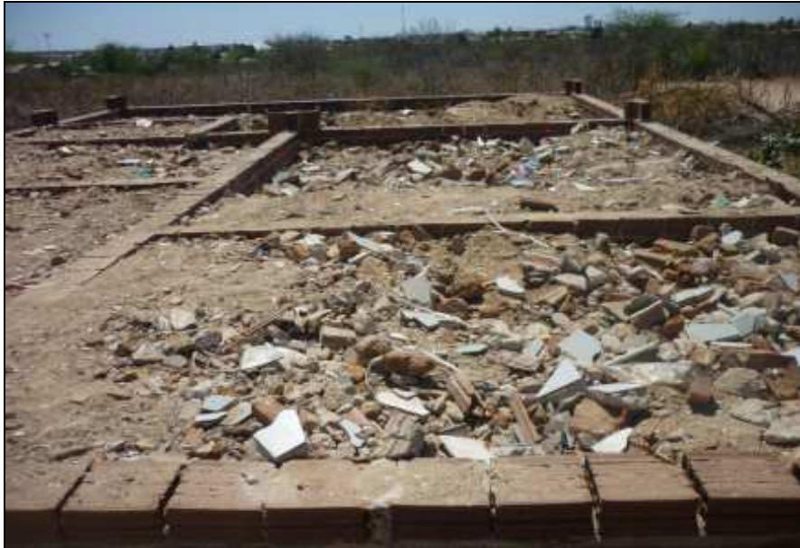
Figura 16 - Aplicação dos RCC em baldrames Fonte: Dantas (2011)
