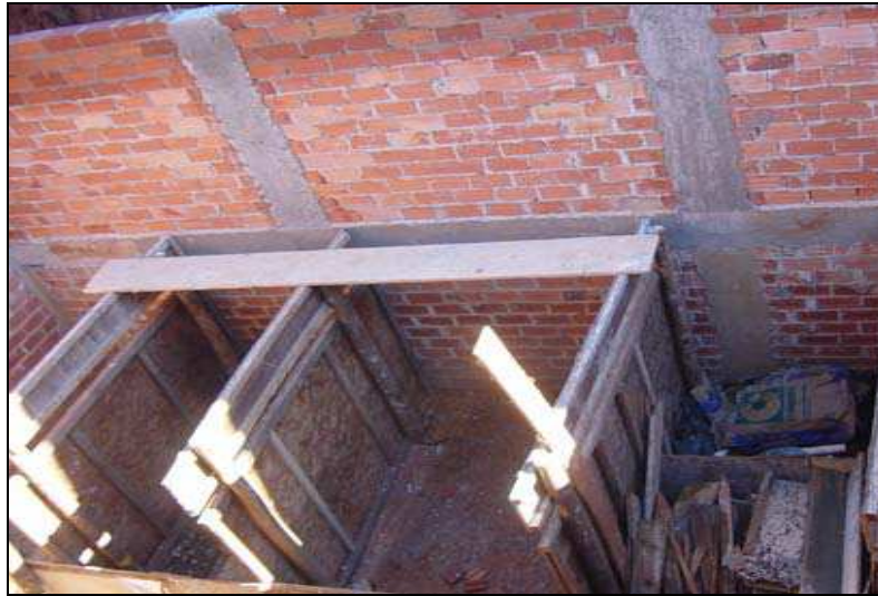
Figura 13 - Baias para separação dos RCC no canteiro de obras Fonte: Tozzi (2006)
