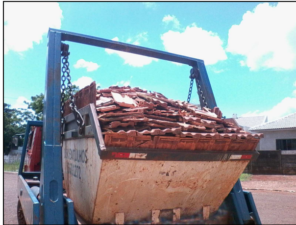
Figura 12 - Material que poderia ser reaproveitado
