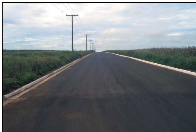
Figura 3 - Pista pavimentada com agregados reciclados de RCC Fonte: Moreira, Dias e Rezende (2007)
