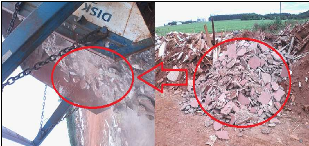
Figura 7 - Descarte dos RCC de reforma e demolição
