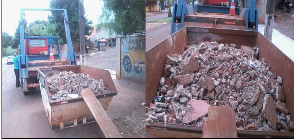
Figura 6 - Retirada da caçamba com RCC de reforma e demolição
