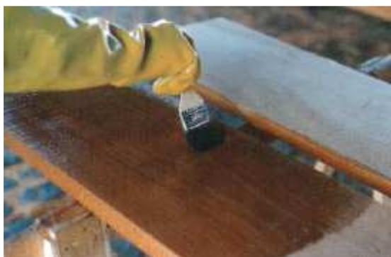
**Figura 20 - Aplicação do preservante por pincelamento em peça pronta para instalação**
