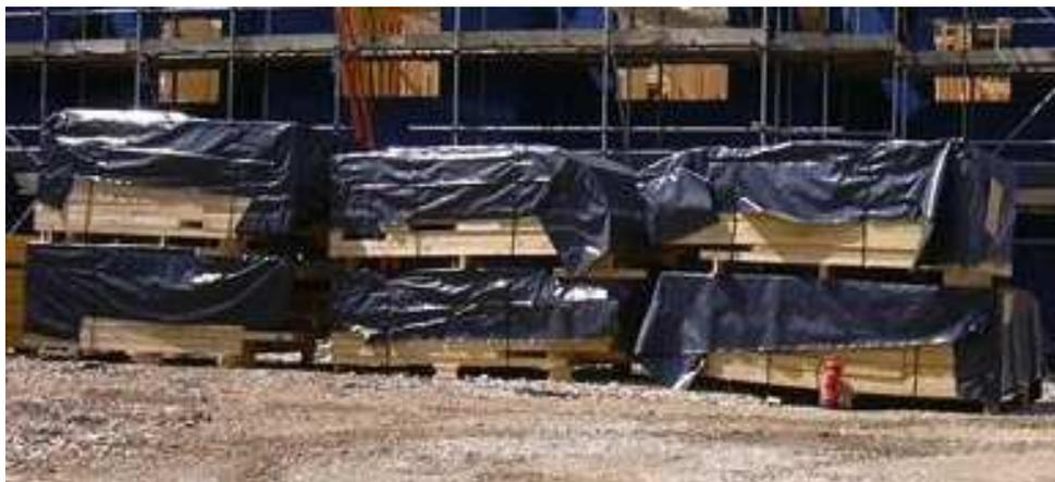
**Figura 35 - Correta armazenagem da madeira em canteiro de obra
