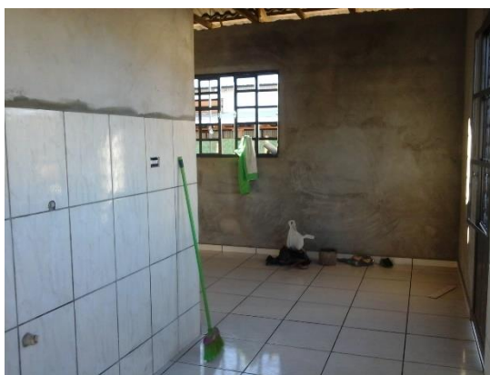
Figura 13 – Execução de revestimento cerâmico
