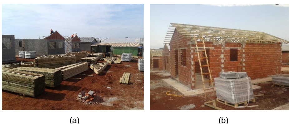
Figura 11 – Execução da cobertura – (a) início e (b) fim de execução da estrutura.
