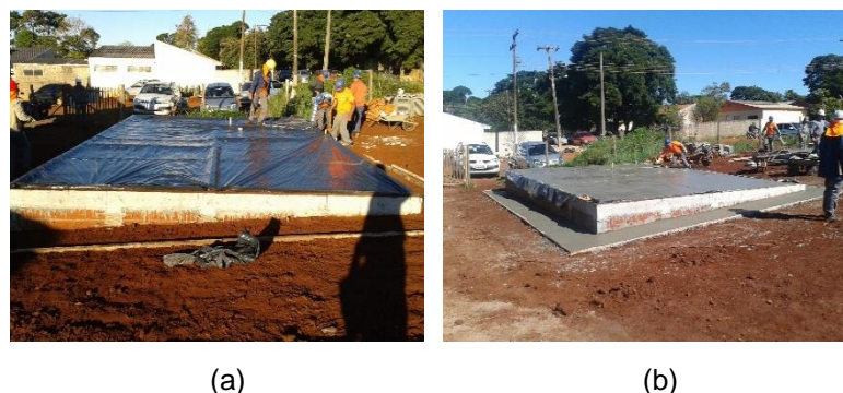
Figura 7 – Serviço de concretagem do contrapiso – (a) aplicação da manta e (b) concretagem. Fonte: do autor (2014).
