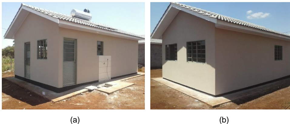
Figura 4 – Habitação de Interesse Social estudada – (a) frente e (b) fundos da casa Fonte: do autor (2014).
