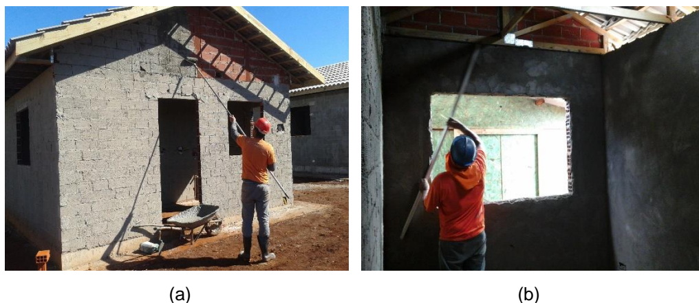
Figura 12 – Execução de (a) chapisco rolado e (b) emboço.
