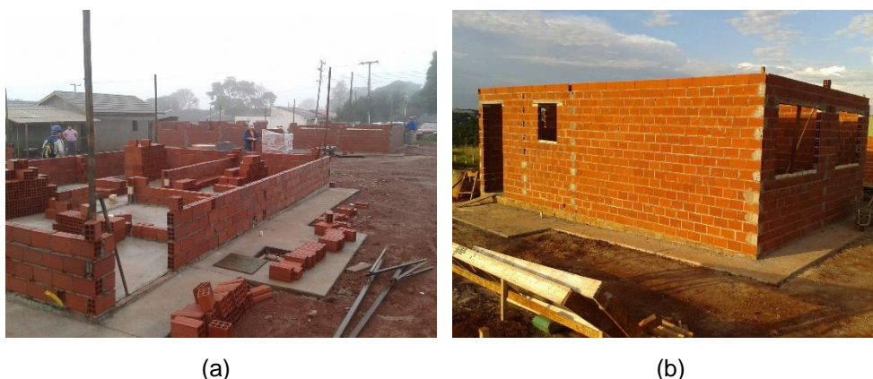
Figura 8 – Execução de alvenaria – (a) início e (b) fim de execução do serviço. Fonte: do autor (2014).
