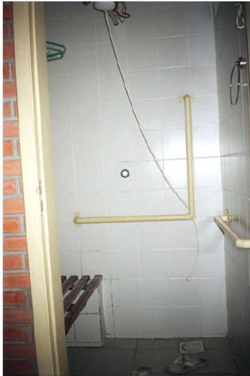
Figura 4: Chuveiro com barras de proteção. Fonte: Rojas, 2005, p. 83.
