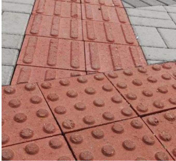
Figura 10: Piso tátil de concreto com alerta direcional. Fonte: site Tecparpavimentos.
