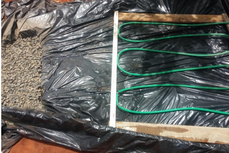
Figura 13: Trincheira de infiltração com simulação de chuva
