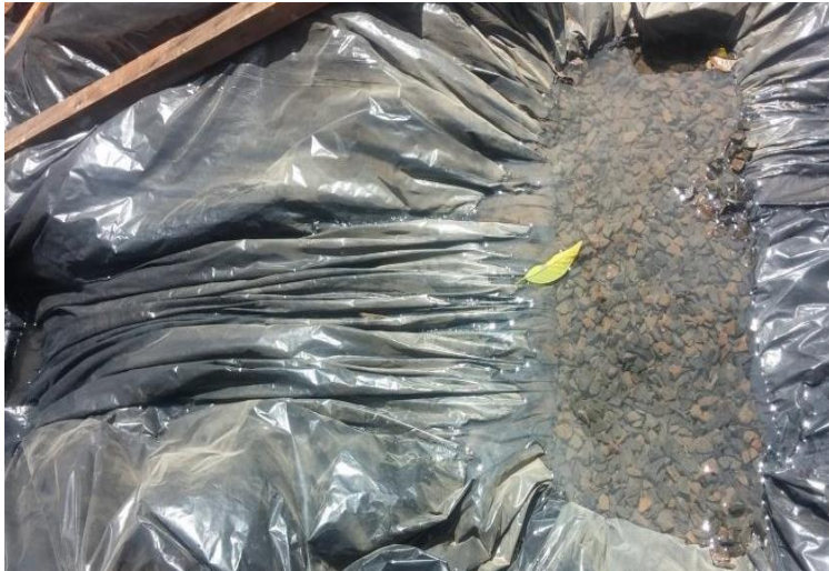
Figura 14: Trincheira no início do transbordo.
