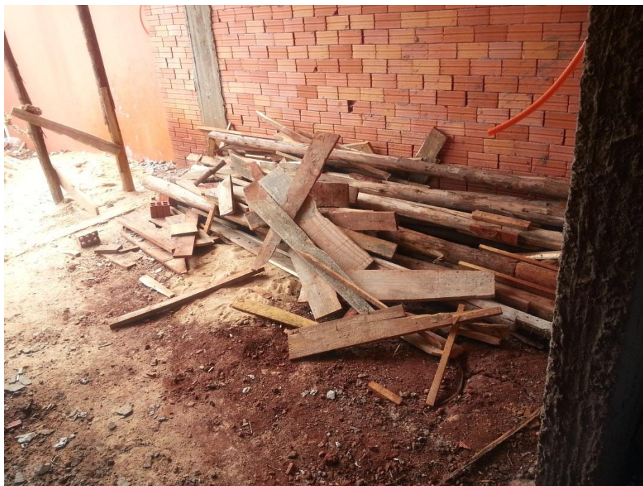
Figura 7 – Armazenamento de resíduos dentro do terreno
