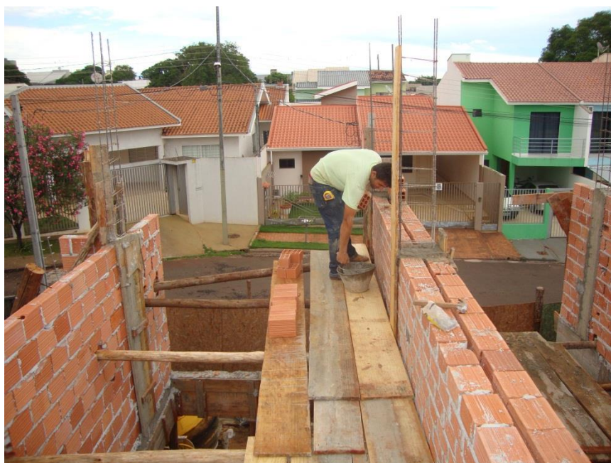
Figura 11 – Operário trabalhando no segundo pavimento
