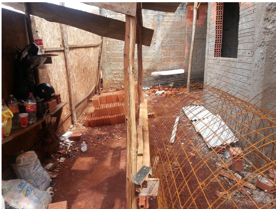
Figura 3 – Armazenamento de materiais no fundo do terreno
