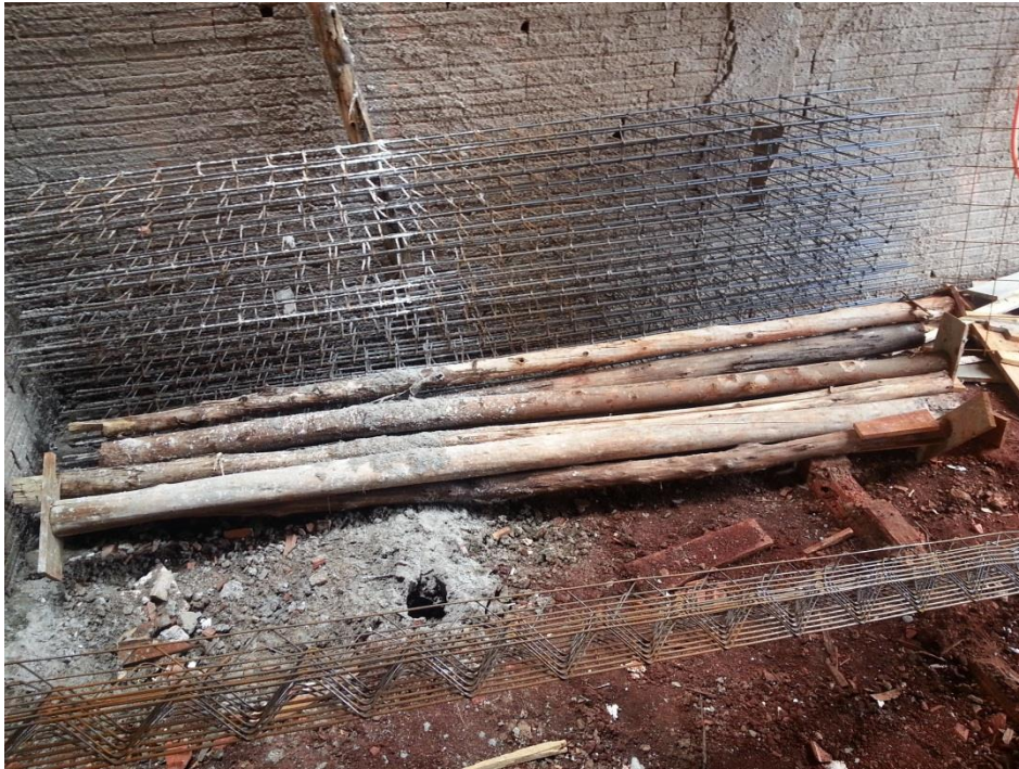
Figura 9 – Armazenamento de matérias de grande comprimento
