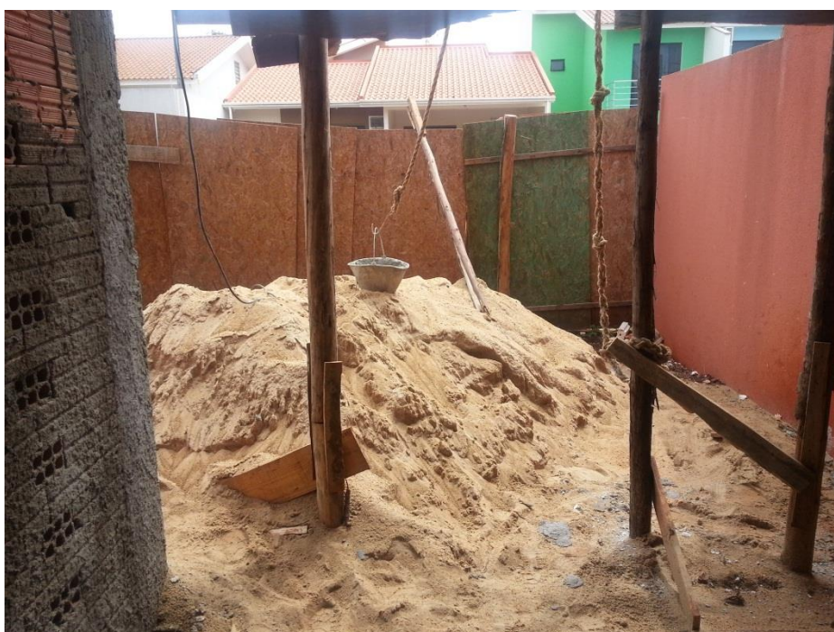
Figura 5 – Armazenamento de materiais na frente do terreno 2
