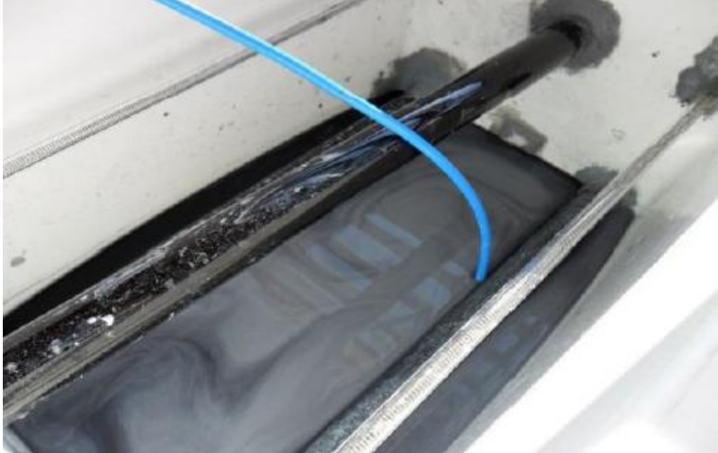
Figura 4: Amostra de efluente de lavanderia no reator.
