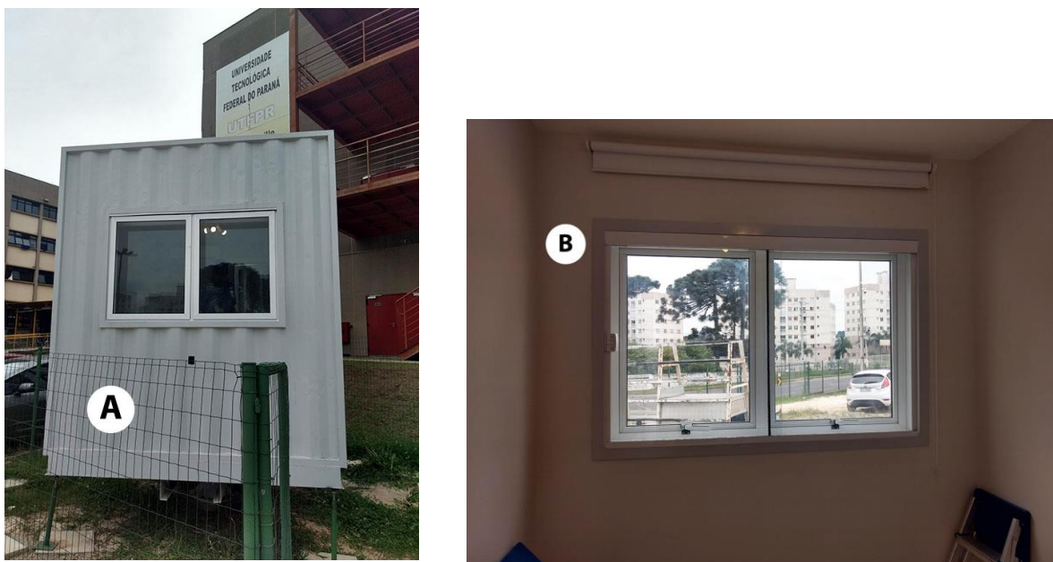
Figura 15 - Janela duplicada em ME: (A) vista externa; (B) vista interna
