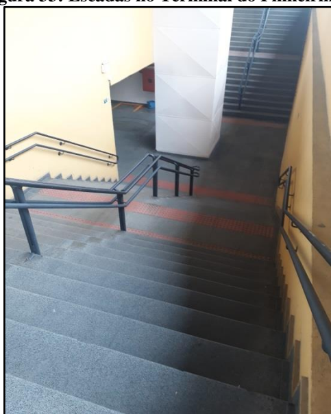
Figura 33: Escadas no Terminal do Pinheirinho.
