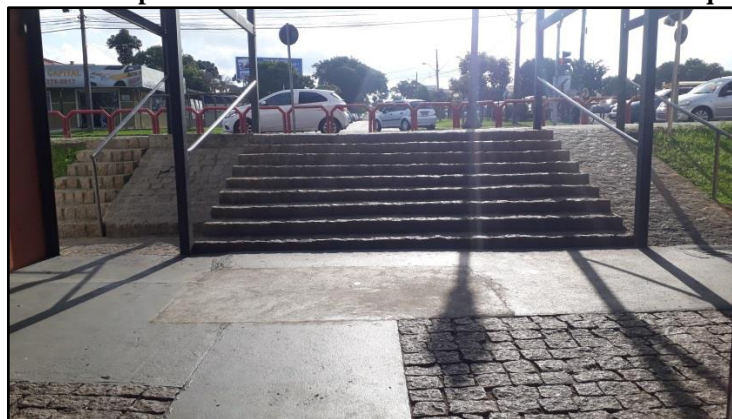
Figura 27: Rampa e escada de acesso da Rua da Cidadania do Boqueirão.
