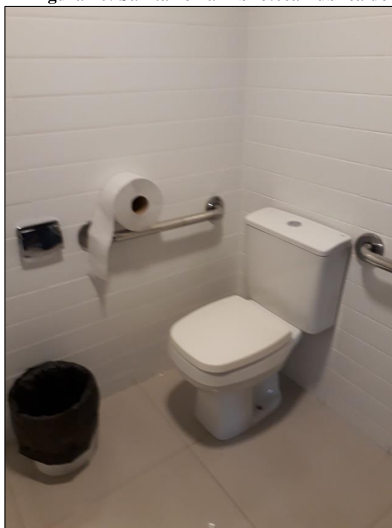
Figura 16: Sanitário na Biblioteca Pública do Paraná
