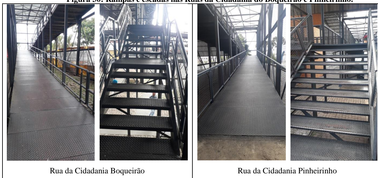
Figura 30: Rampas e escadas nas Ruas da Cidadania do Boqueirão e Pinheirinho.
