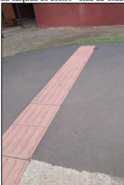
Figura 26: Piso tátil na calçada de acesso - Rua da Cidadania do Pinheirinho.
