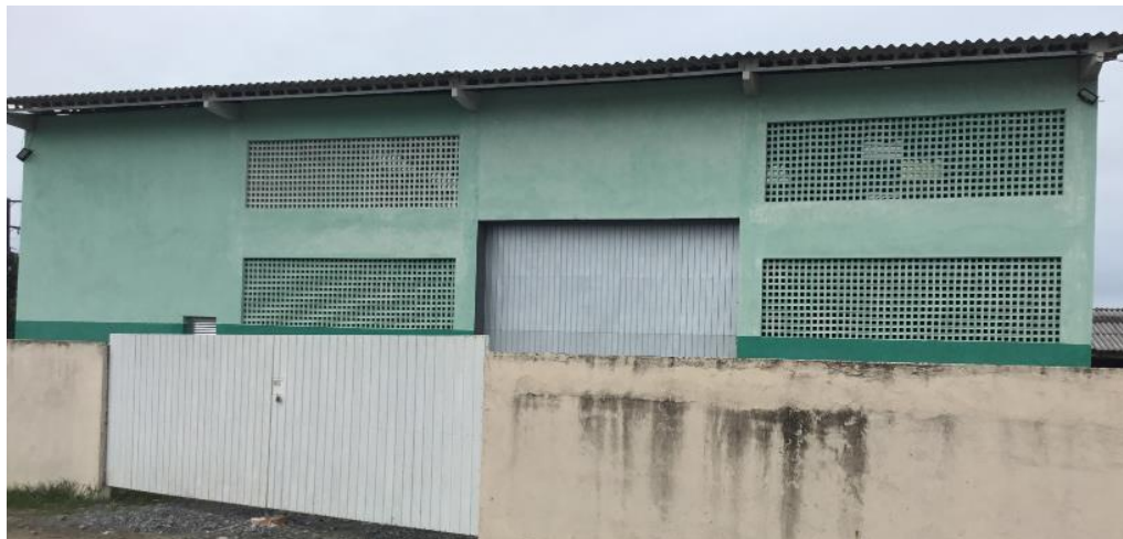
Figura 7 - Barracão para a separação de materiais de Matinhos –PR
