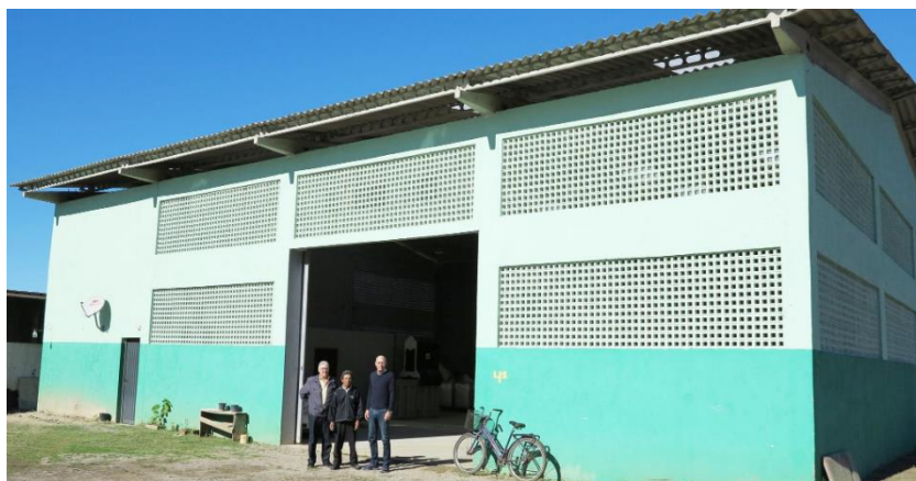
Figura 16 - Entrega do barracão para a AMAGEM pelo prefeito (direita) e Secretário de Meio Ambiente (esquerda)
