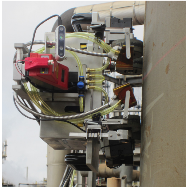
Figura 20 – Robô CRAS realizando testes de movimentação em chaminé descontinuada da Refinaria Presidente Getúlio Vargas (REPAR).
