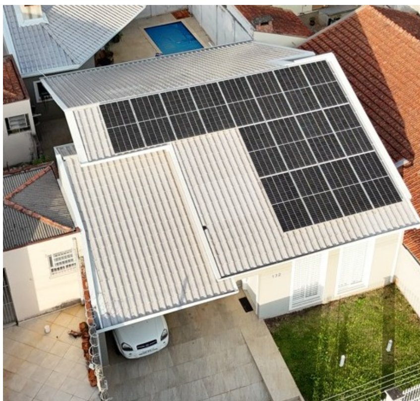
Figura 2 – Local e disposição dos painéis fotovoltaicos
