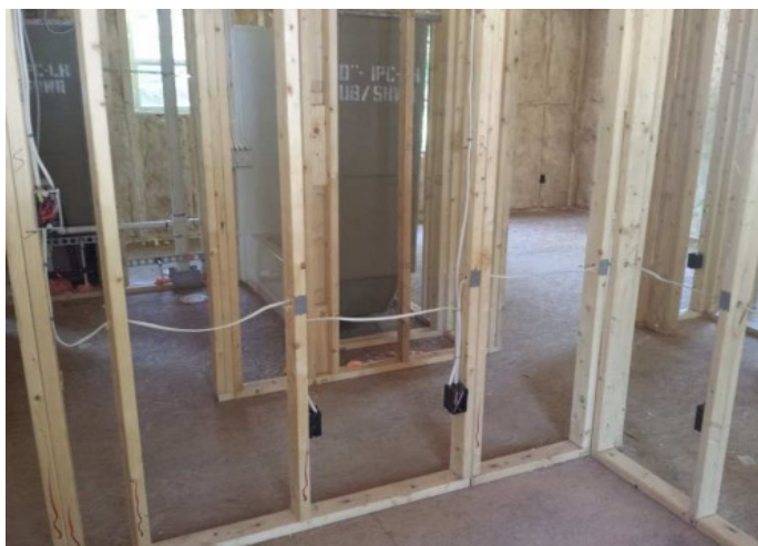
Figura 8 - Sistema elétrico e hidrossanitário
