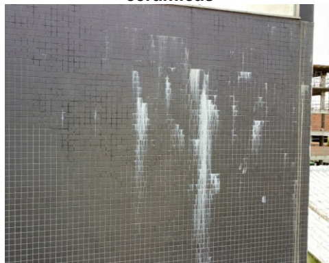
Figura 4 - Presença de manchas de eflorescência na fachada revestida com pastilhas cerâmicas
