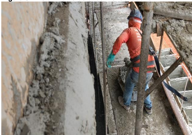
Figura 8 - Vista interna do andaime fachadeiro
