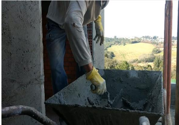
Figura 12 - Preparação da argamassa
