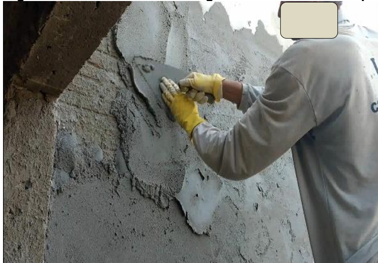
Figura 13 - Sarrafeamento da argamassa com colher de pedreiro
