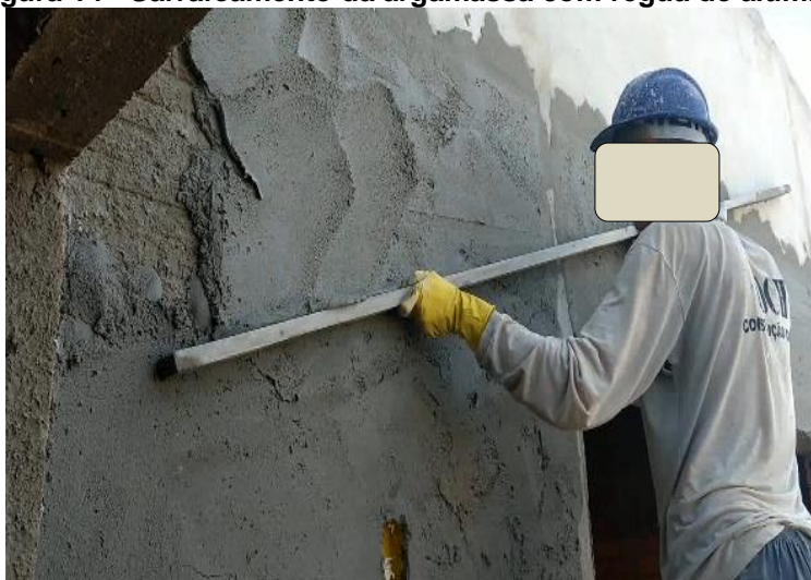
Figura 14 - Sarrafeamento da argamassa com régua de alumínio
