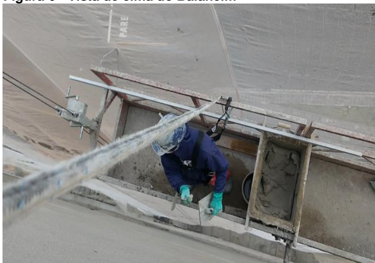
Figura 6 - Vista de cima do Balancim
