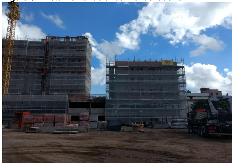
Figura 9 - Vista frontal do andaime fachadeiro
