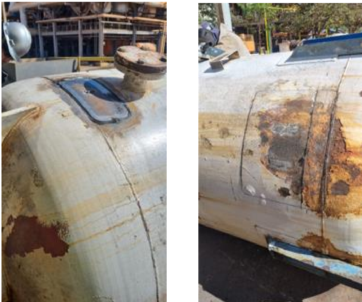
Figuras 17 e 18 – Evidências Rompimento Filtro de Carvão.
