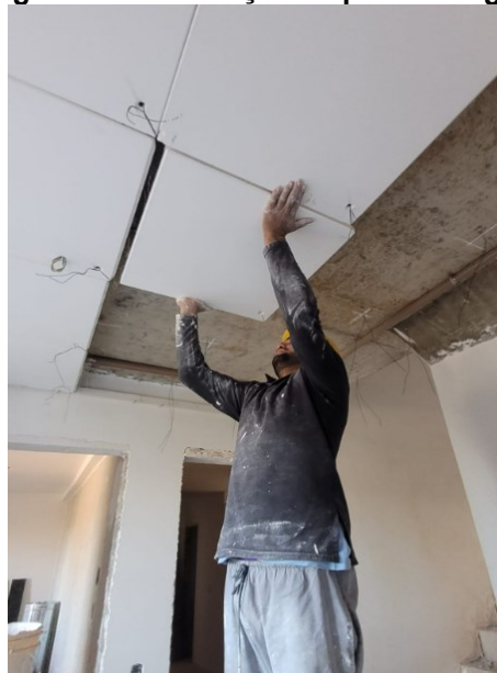
Fotografia 9 – Instalação de placas de gesso
