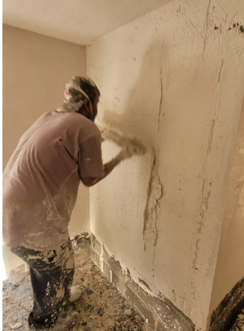
Fotografia 2 – Sarrafeamento do gesso
