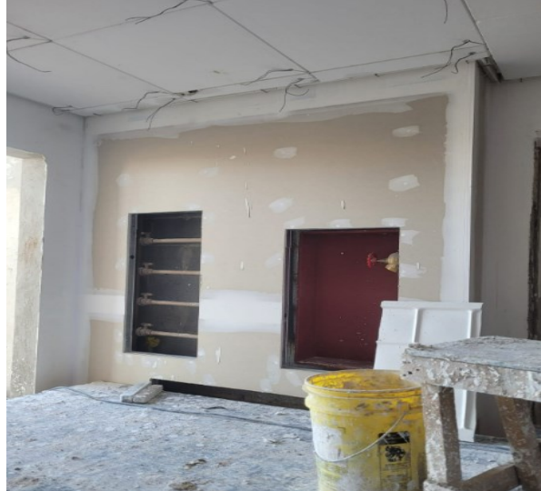
Fotografia 8 – Instalação do drywall
