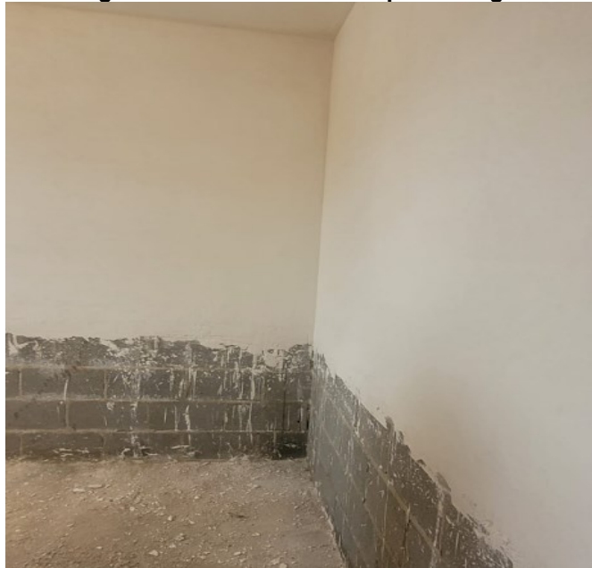
Fotografia 4– Acabamento da pasta de gesso
