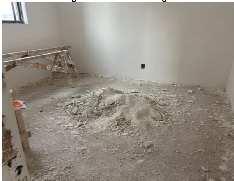
Fotografia 5 – Resíduos de gesso
