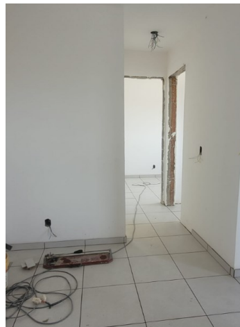
Fotografia 12 – Instalação do piso cerâmico
