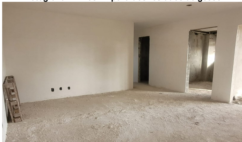
Fotografia 7 – Pós limpeza dos resíduos de gesso
