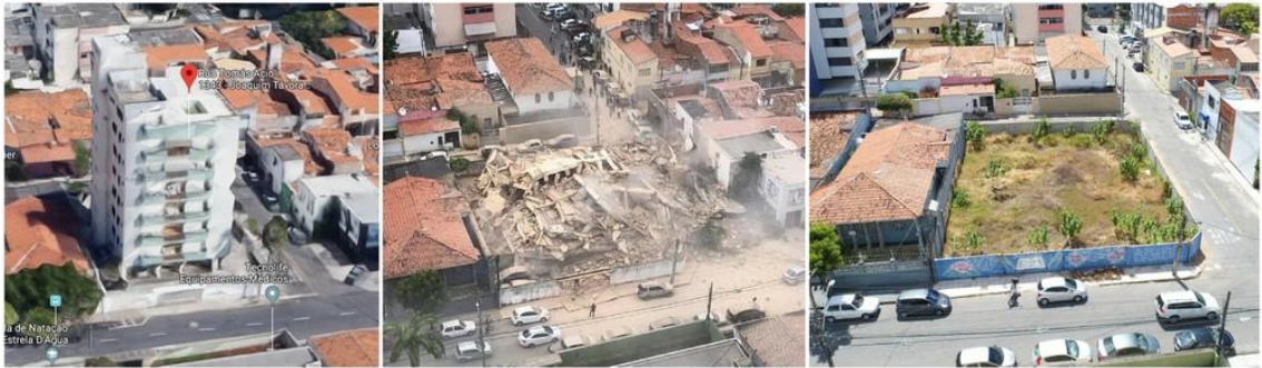
Figura 1 - Desabamento do edifício em Fortaleza.
