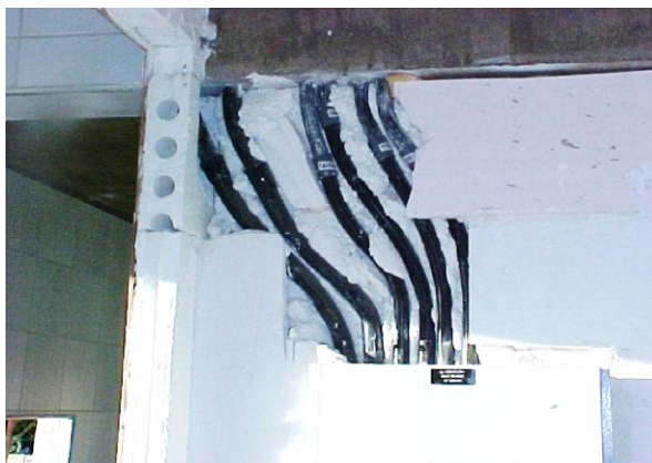
Fotografia 1 - Gesso aplicado em quadros de distribuição
