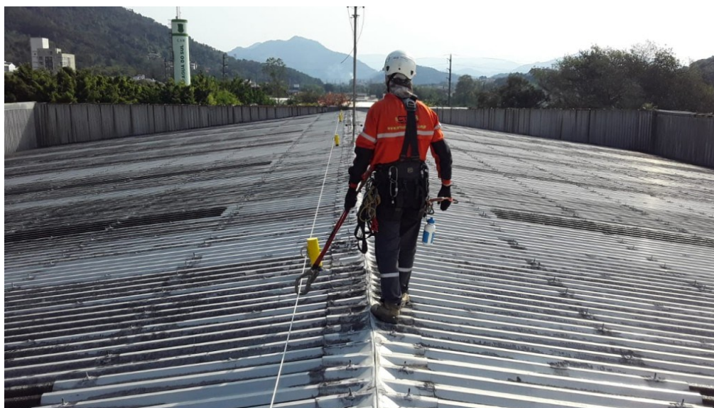
Figura 1 - Linha de vida horizontal flexível
