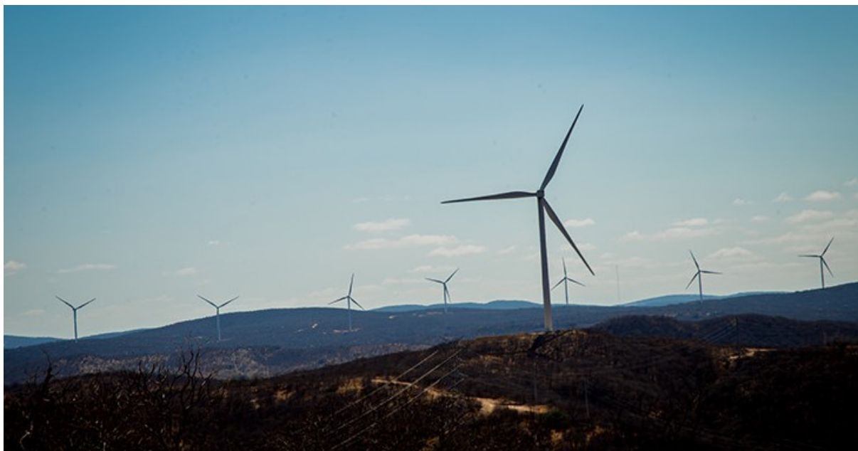
Figura 10 - Parque eólico onshore de Chafariz
