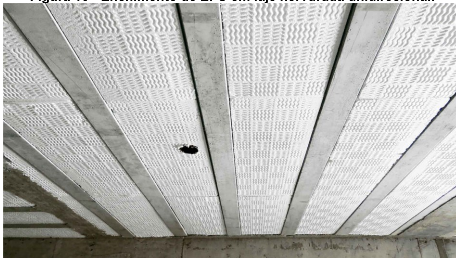
Figura 10 - Enchimento de EPS em laje nervurada unidirecional.
