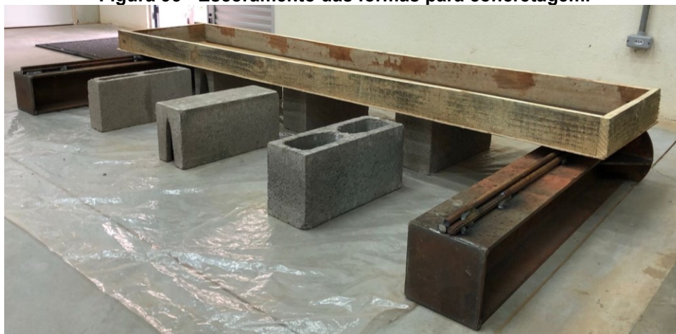
Figura 35 - Escoramento das formas para concretagem.
