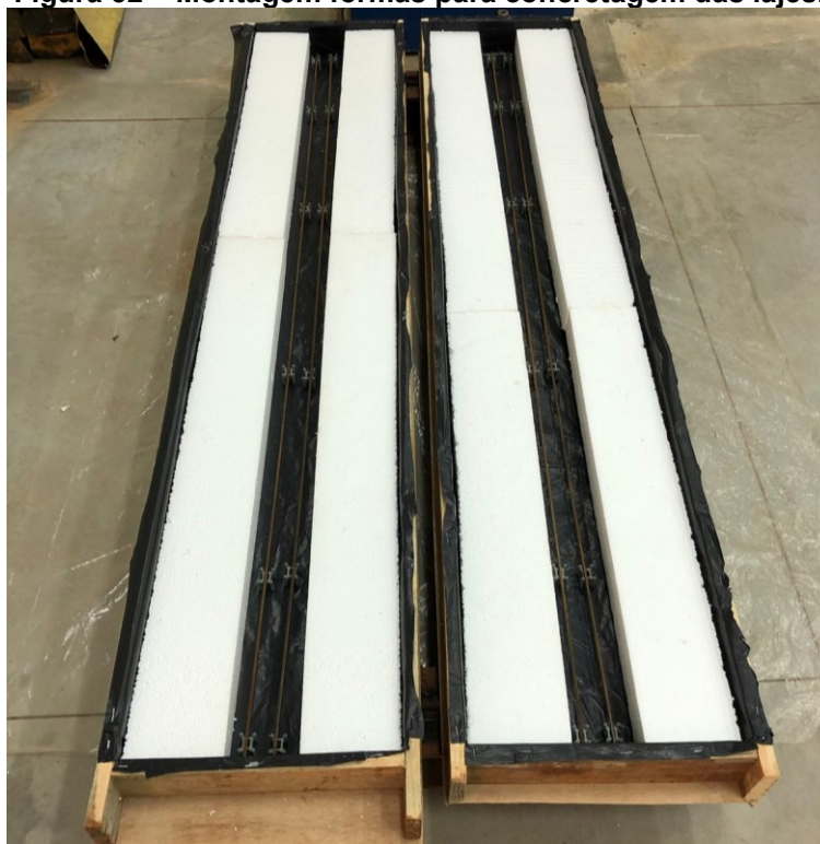
Figura 32 – Montagem formas para concretagem das lajes.
