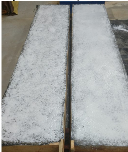
Figura 40 - Lajes concretadas em processo de cura química.
