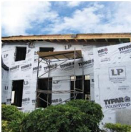
Figura 9 - Membrana hidrófuga em estrutura em Wood Frame
