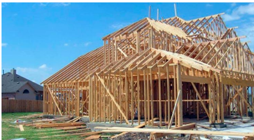
Figura 1 - Construção em Wood Frame
