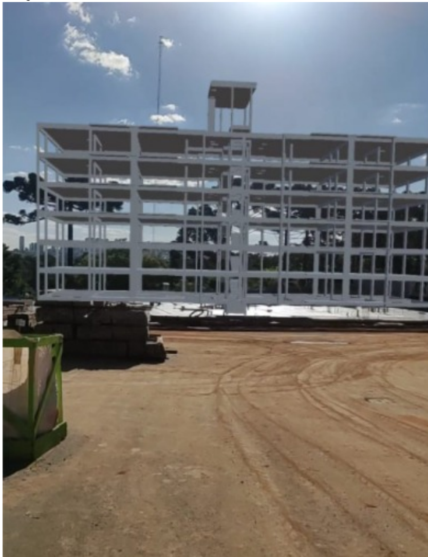
Figura 28: Aplicação de realidade aumentada no canteiro de obras
