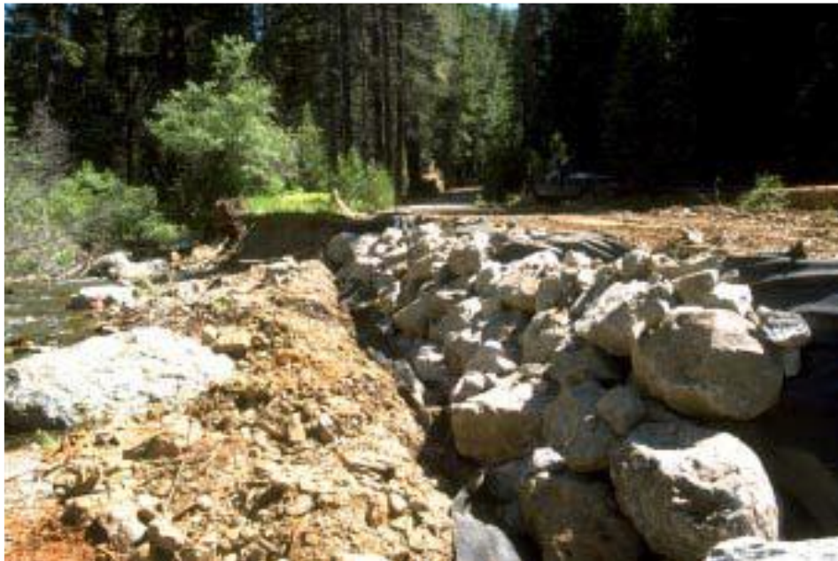
Figura 10: Proteção da estrada contra o alto fluxo de água utilizando riprap e geotêxtil. (Keller et al. , 2003).
