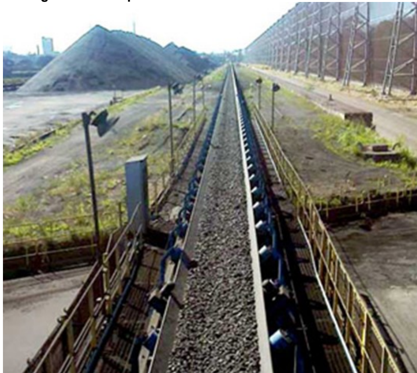
Figura 1 - Transportador de correia na indústria de minério
