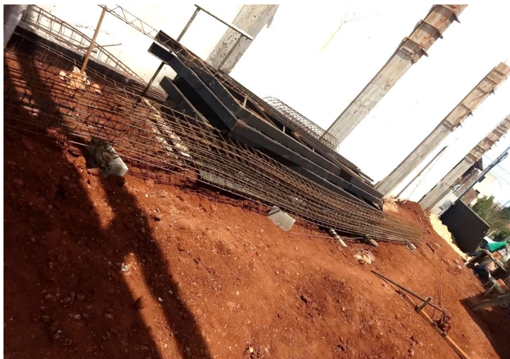
Figura 31 – Armazenamento de ferragens armadas e treliças metálicas de cobertura no canteiro de obras.
