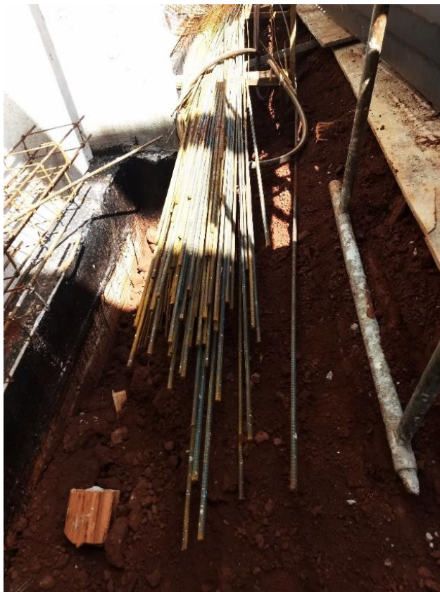
Figura 26 – Vergalhões de aço armazenados no canteiro de obras.
