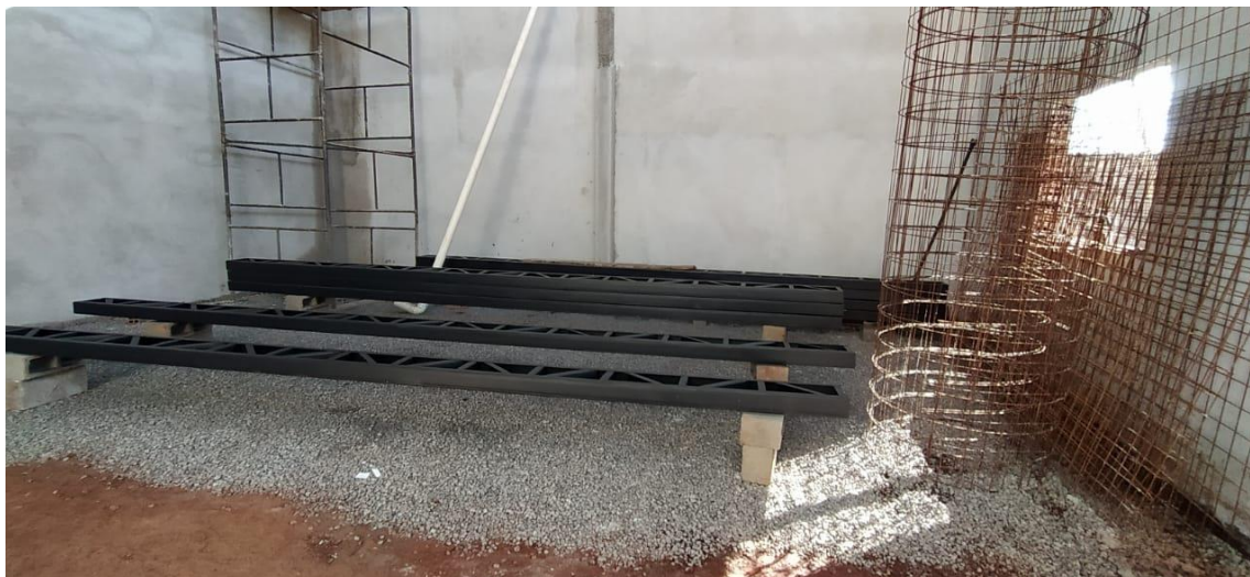
Figura 32 – Armazenamento de treliças metálicas de cobertura no canteiro de obras.
