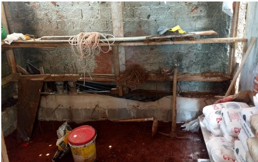
Figura 34 – Equipamentos e materiais armazenados no abrigo da obra.
