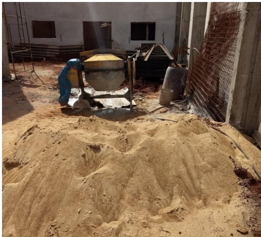
Figura 11 – Areia posicionada próxima a betoneira.
