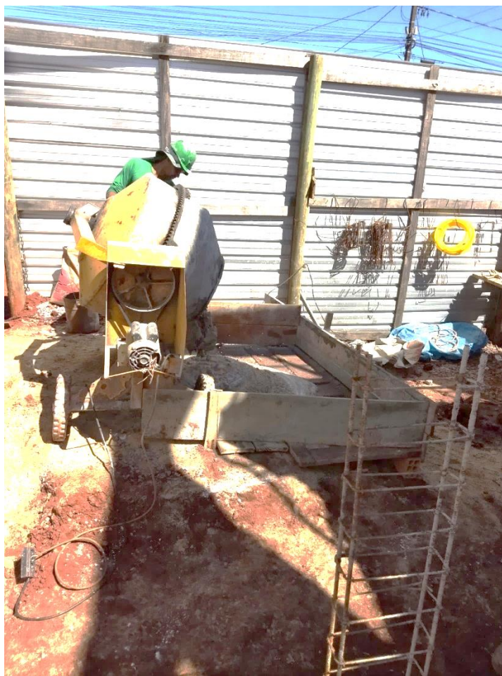
Figura 15 – Caixa de massa e betoneira da obra.
