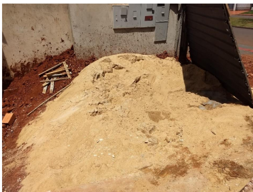
Figura 13 – Areia posicionada na entrada do canteiro de obras.
