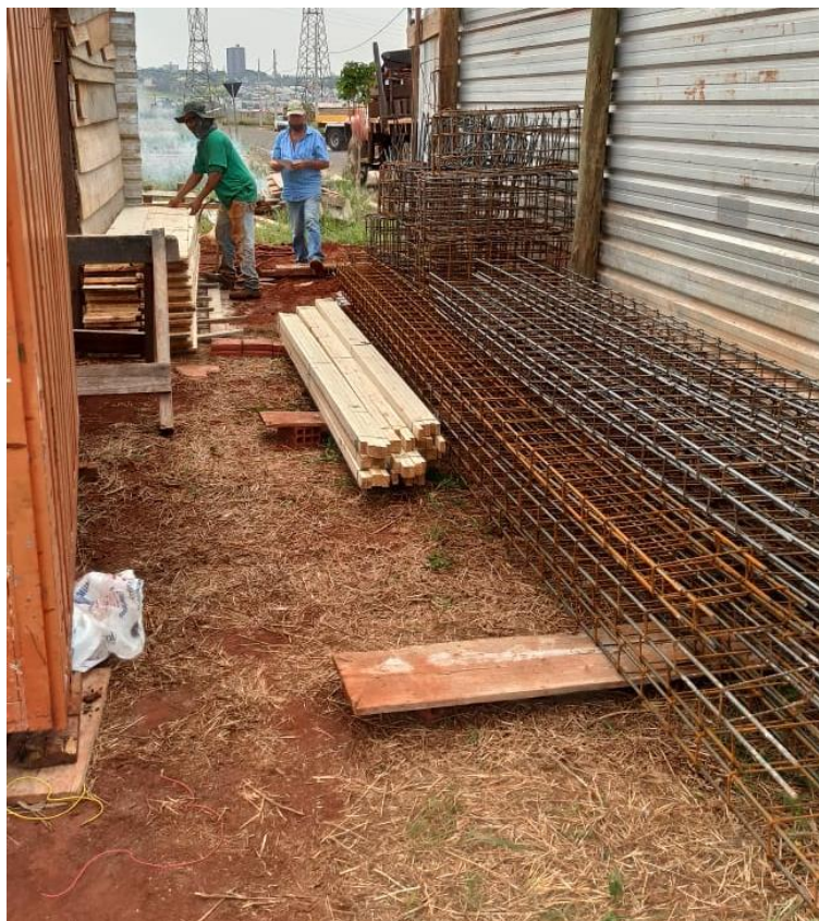
Figura 29 – Armazenamento de ferragens armadas no canteiro de obras.
