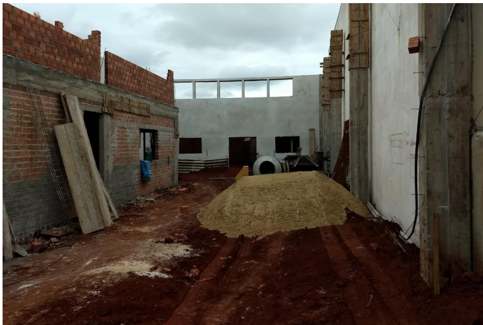
Figura 12 – Areia armazenada no canteiro de obras.
