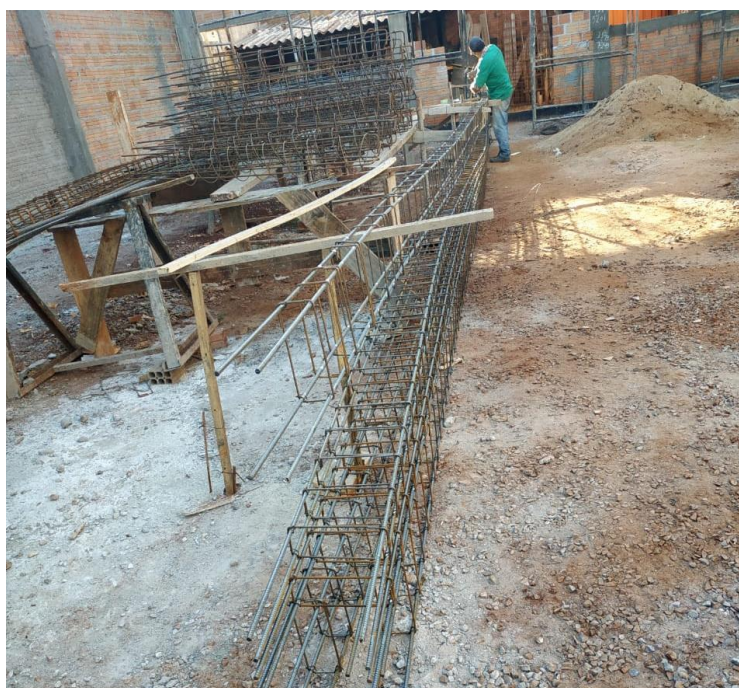
Figura 28 – Ferragens de vigas e pilares armadas no canteiro de obras.
