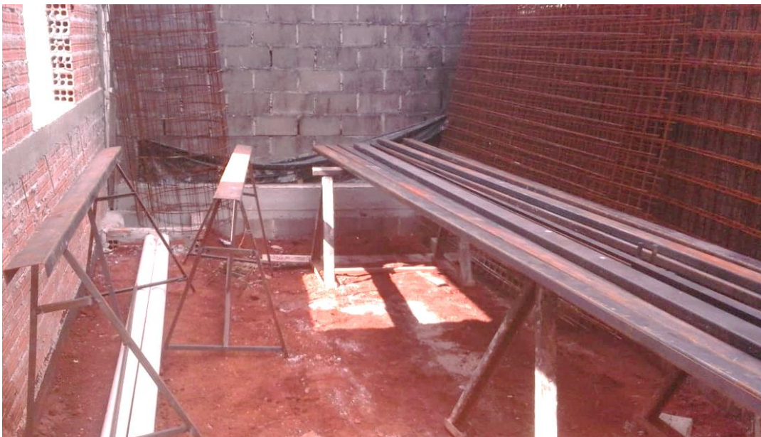
Figura 27 – Telas de ferro metálicas armazenadas no canteiro de obras.
