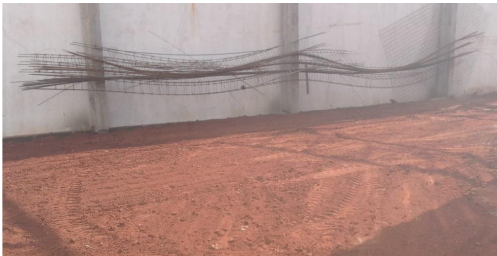
Figura 30 – Armazenamento de ferragens no canteiro de obras posicionadas junto a parede.
