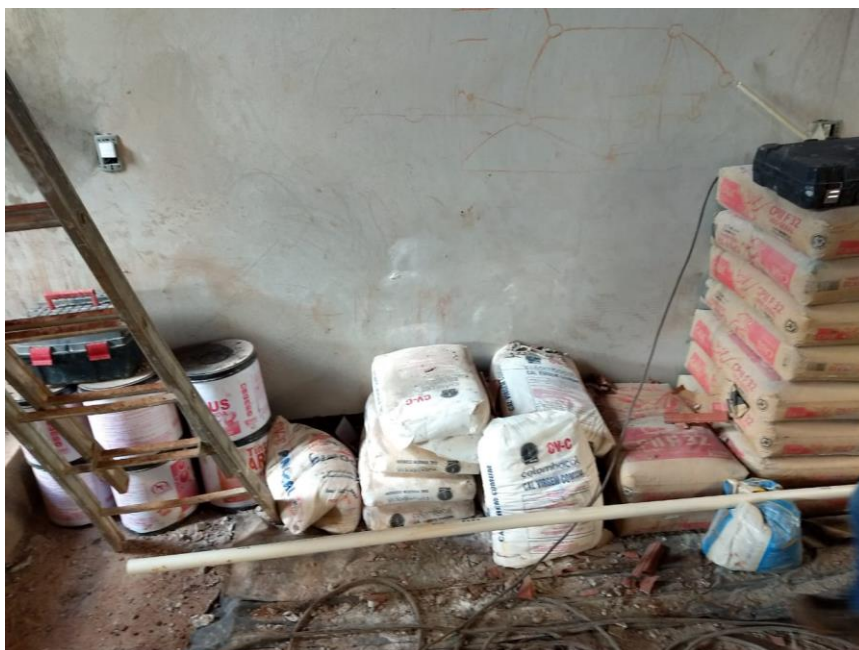
Figura 23 – Sacos de cimento e cal virgem armazenados no canteiro de obras em local protegido.
