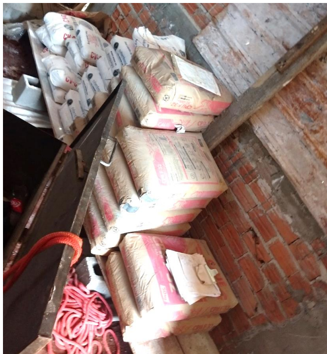
Figura 22 – Sacos de cimento e cal virgem armazenados no canteiro de obras.
