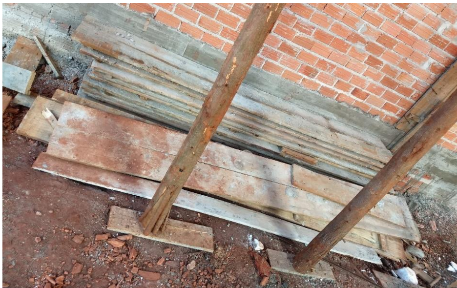
Figura 33 – Armazenamento de tábuas de madeira no canteiro de obras.
