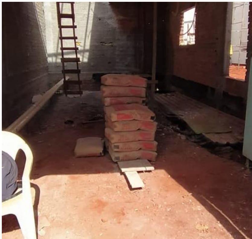
Figura 21 – Sacos de cimento armazenados no canteiro de obras.
