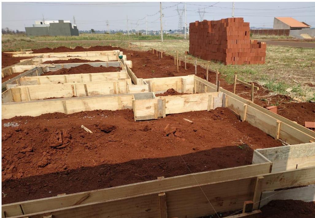
Figura 16 – Blocos cerâmicos posicionados ao lado do canteiro de obras.
