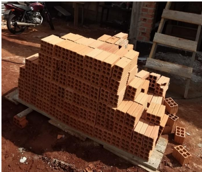
Figura 17 – Blocos cerâmicos armazenados no canteiro de obras.
