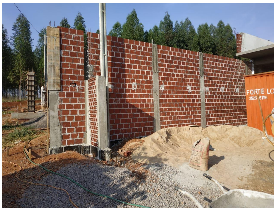
Figura 10 – Areia e brita posicionadas na entrada da obra.
