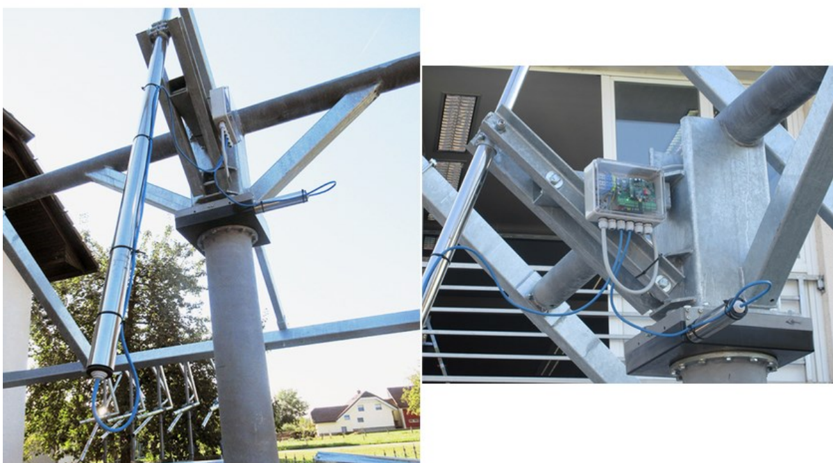
Figura 6 – Seguidor Solar de eixo duplo ST54M3S30 sistema de movimentação
