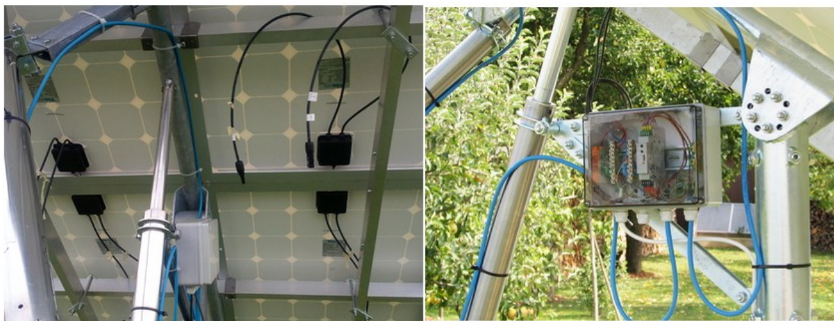
Figura 7 – Seguidor solar de eixo duplo ST44M2V4P sistema de movimentação
