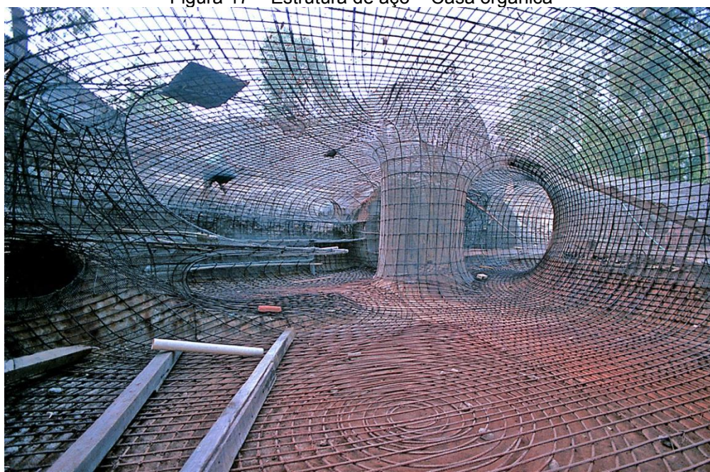
Figura 17 – Estrutura de aço – Casa orgânica
