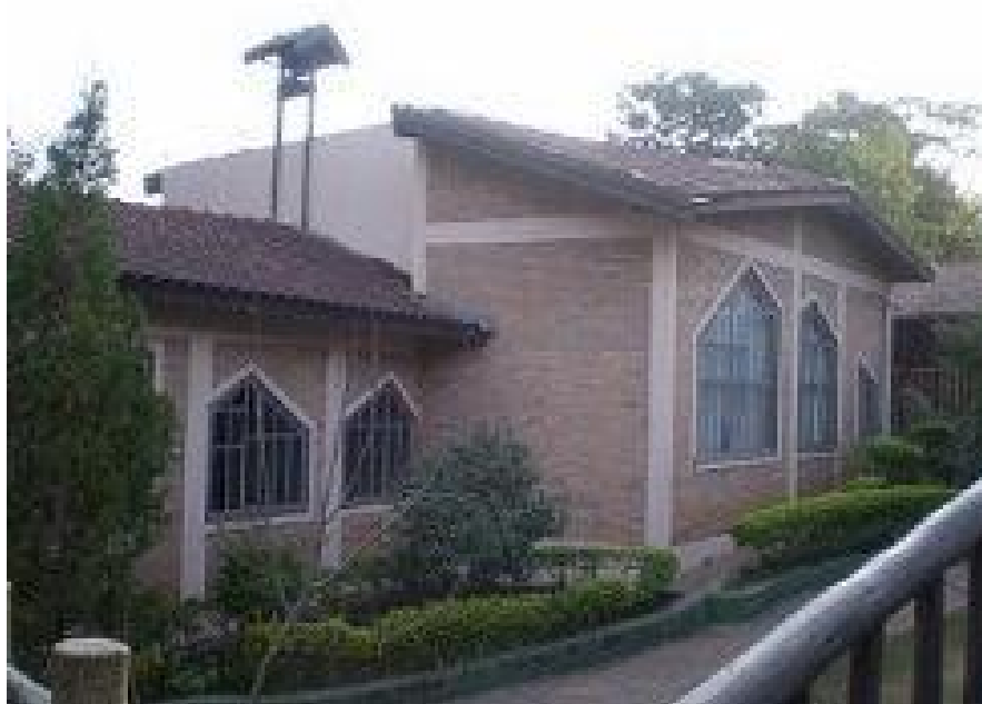
Figura 5 –Esquadrias de uma escola.
