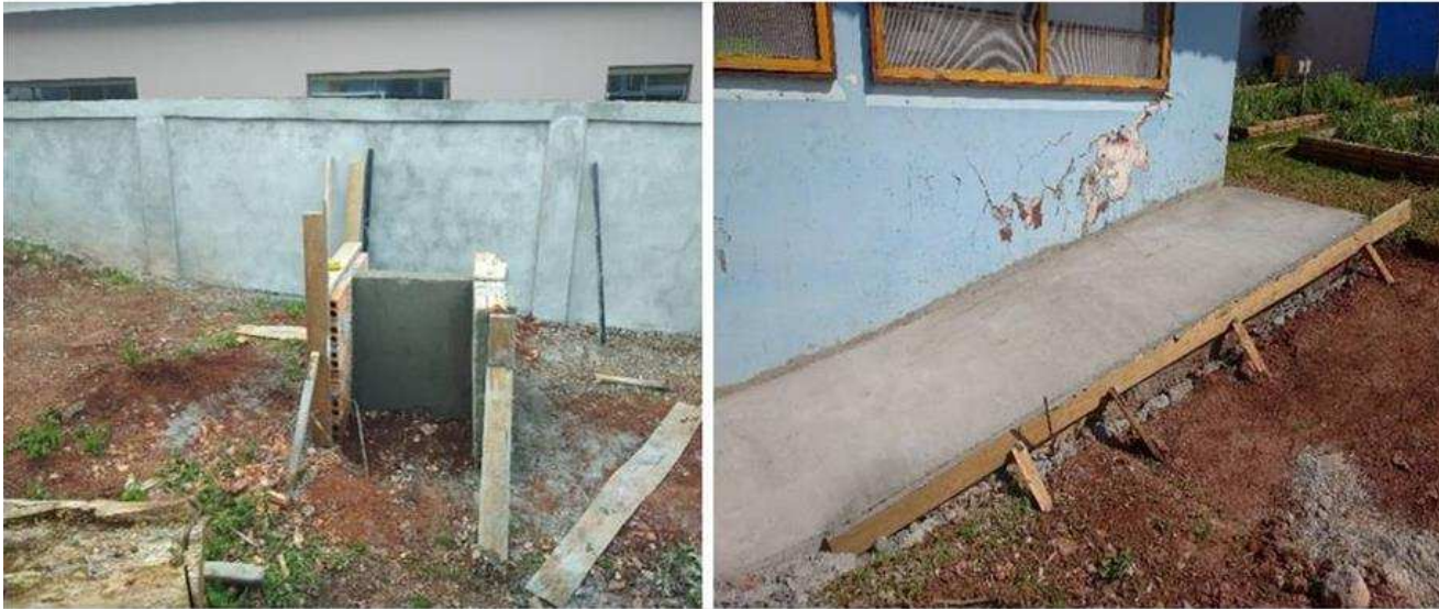
Figura 06: Fotos da bancada e rampa em fase de construção na horta da escola.
