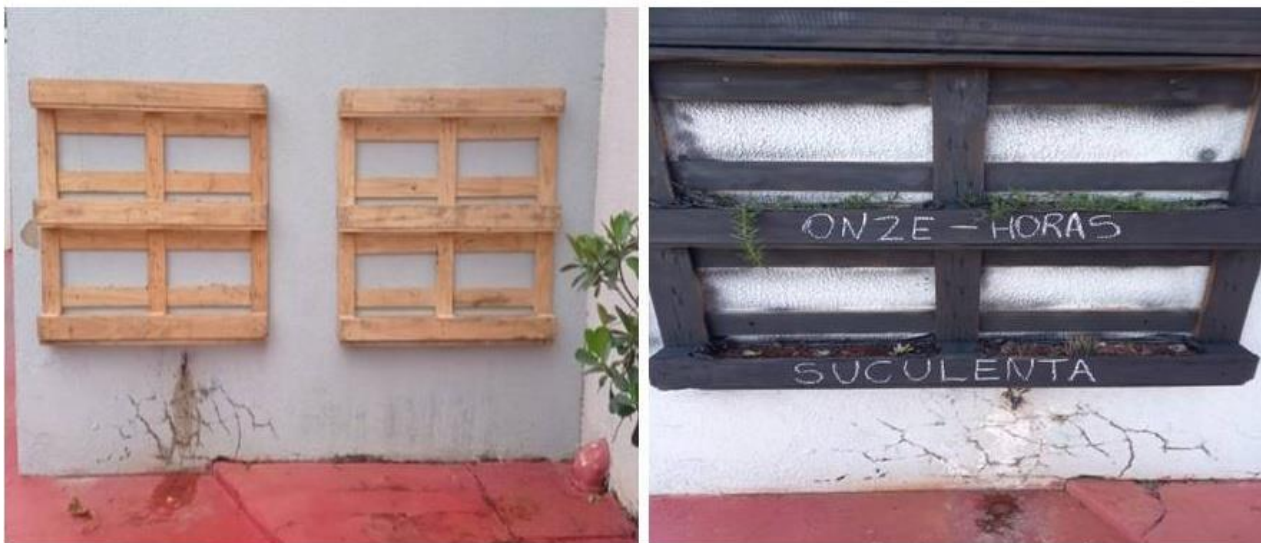
Figura 11: Canteiro suspenso em fase de acabamento utilizando pallets
