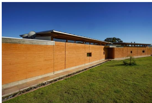
Figura 5 - Edificação em paredes monolíticas de solo-cimento
