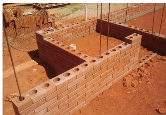
Figura 4 - Alvenaria estrutural em blocos de solo-cimento
