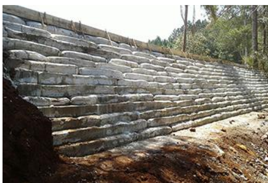
Figura 3 - Estabilização de talude com solo-cimento ensacado
