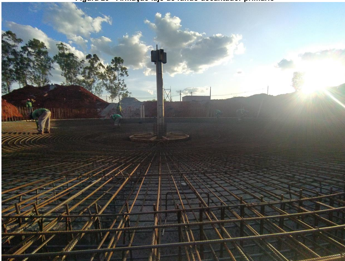
Figura 29 - Armação laje de fundo decantador primário
