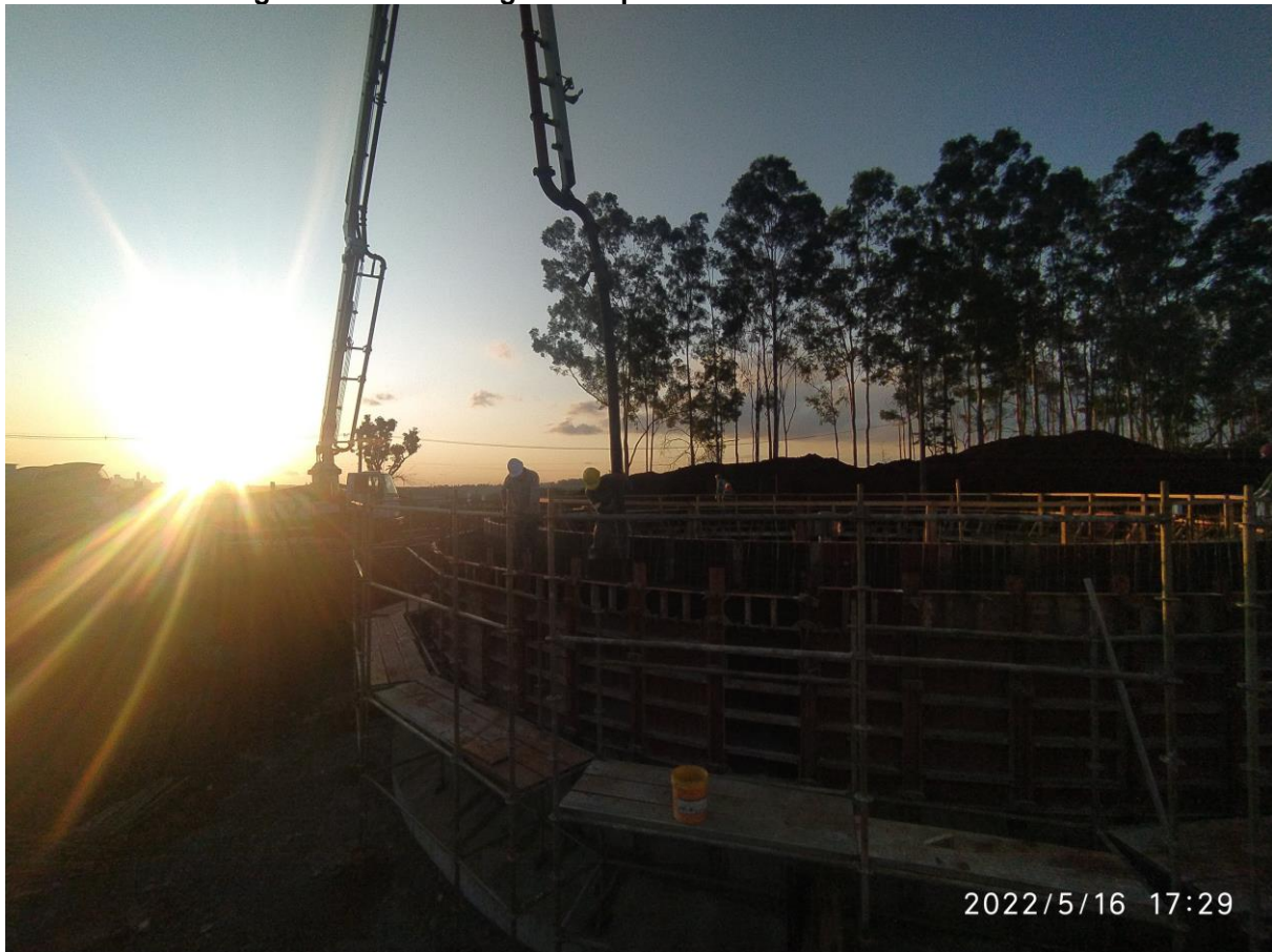
Figura 31 - Concretagem das paredes do Decantador Primário
