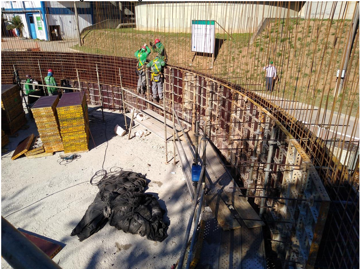
Figura 14 - Montagem e travamento das formas metálicas
