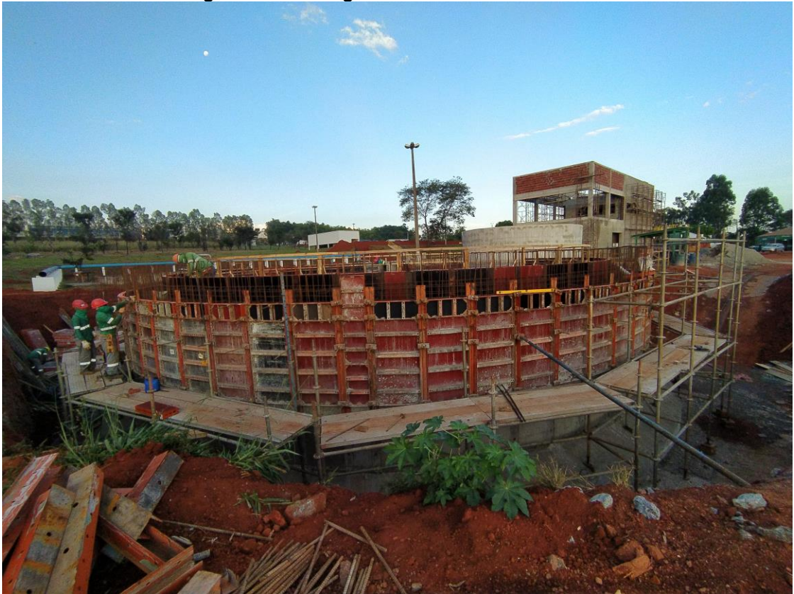
Figura 30 - Montagem e travamento das fôrmas
