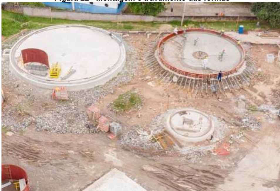
Figura 22 - Montagem e travamento das fôrmas
