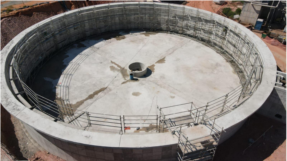
Figura 16 - Decantador Primário finalizado
