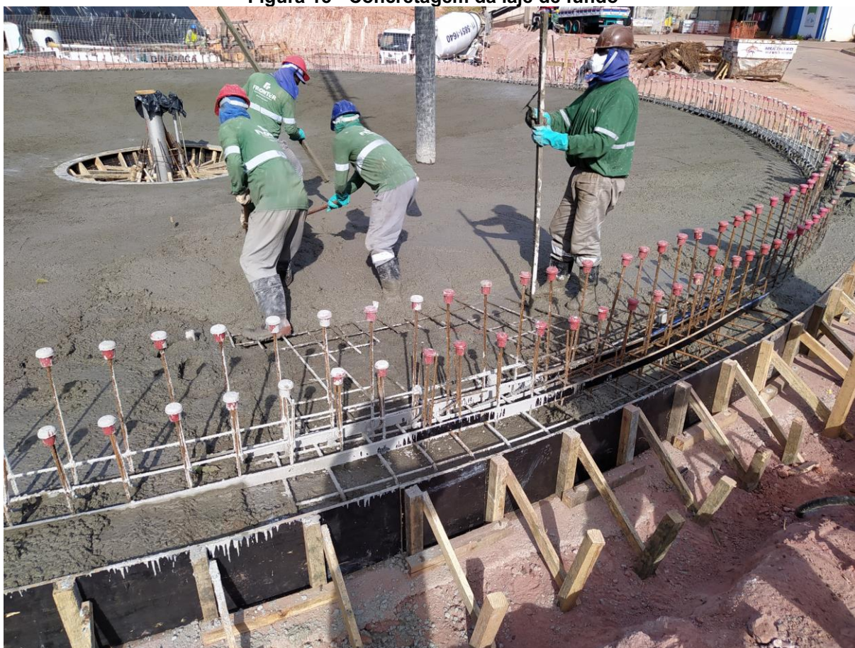
Figura 15 - Concretagem da laje de fundo
