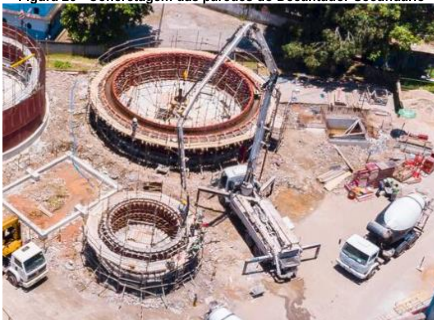
Figura 23 - Concretagem das paredes do Decantador Secundário
