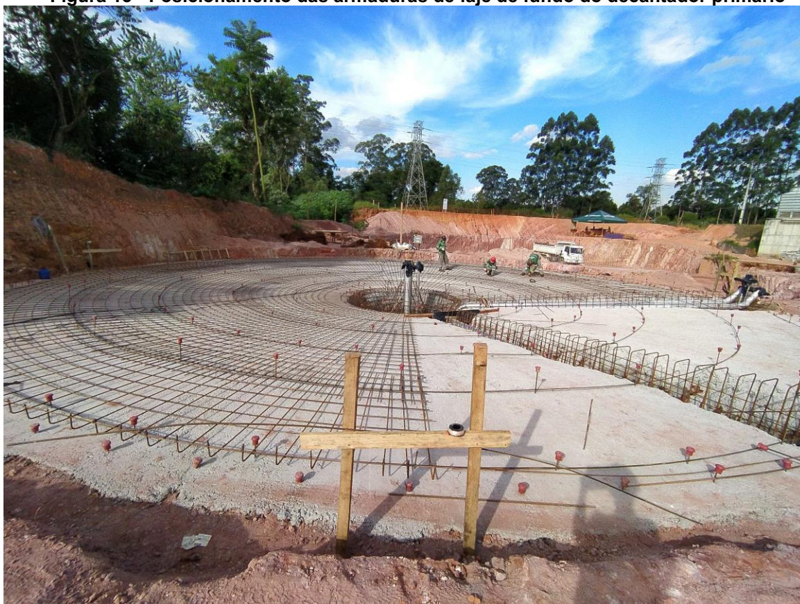
Figura 13 - Posicionamento das armaduras de laje de fundo do decantador primário
